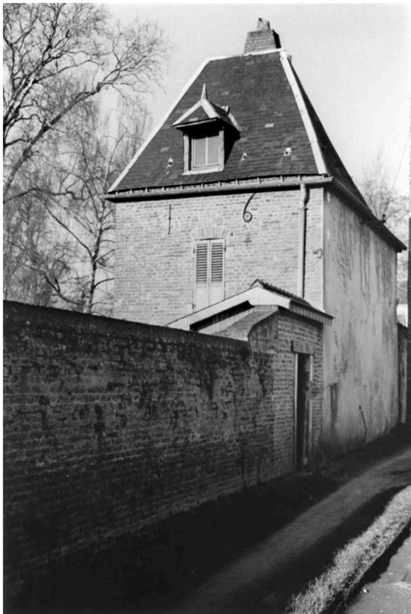
Vue générale du pavillon depuis l'impasse.
