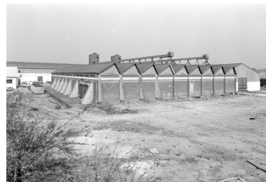
Vue du flanc sud de l'usine. Phot. Thierry Lefébure IVR22_19888000616Z
