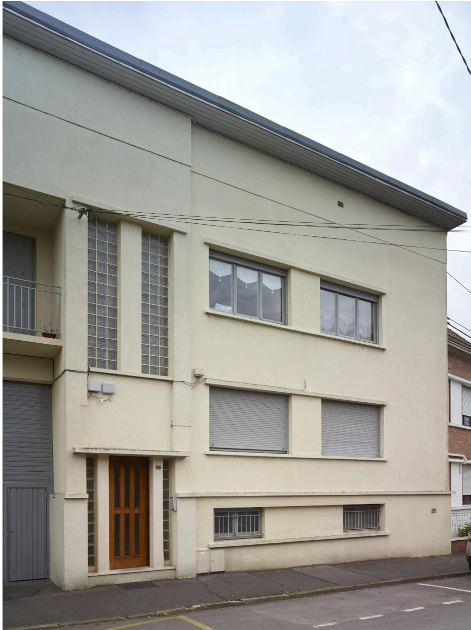
Détail de la partie droite (n°3) de l'immeuble. Vue orientée est/ouest.
