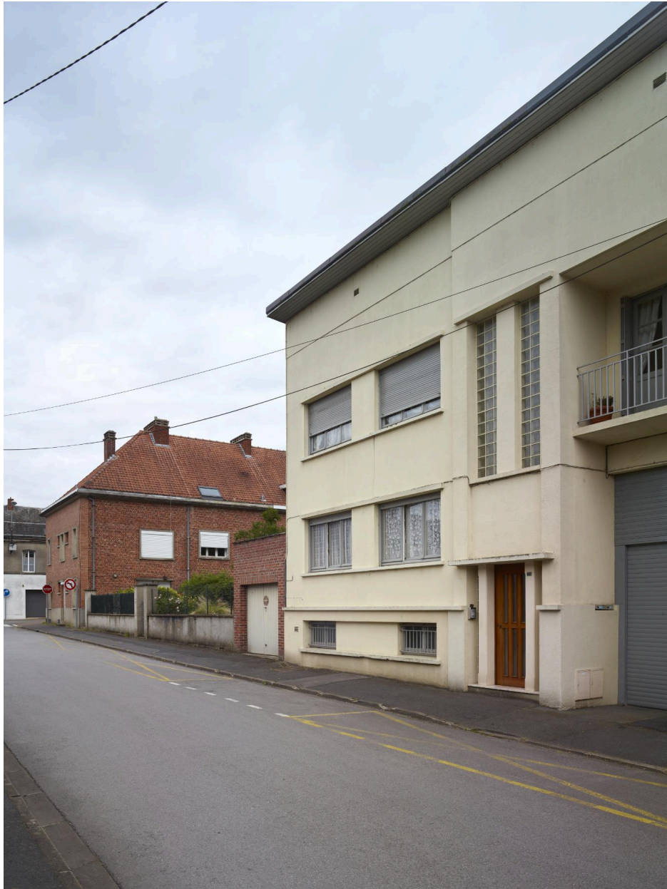
Détail de la partie gauche (n°1) de l'immeuble. Vue orientée ouest/est.
