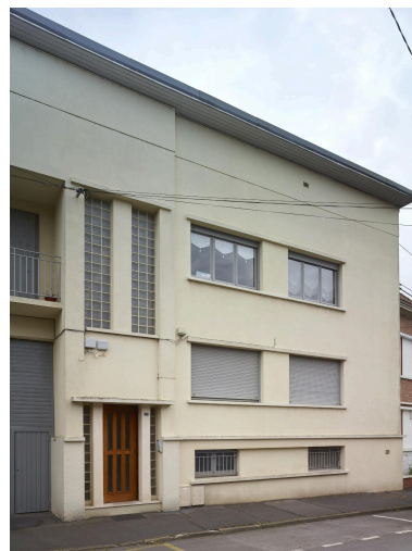
Détail de la partie droite (n°3) de l'immeuble. Vue orientée est/ouest. Phot. Pierre Thibaut IVR32_20245900185NUCA
