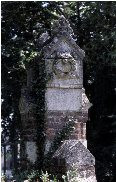
Le portail d'entr e, rue d'Elbeuf, vue du pilier. Phot. Marie-Laure Monnehay-Vulliet IVR22_20078000216XA
