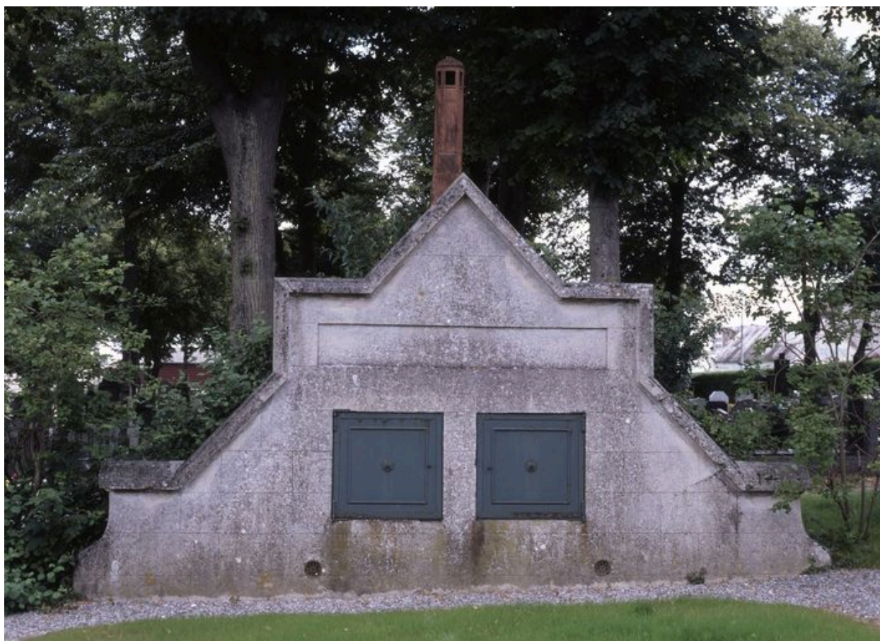
Le dépositoire, vue depuis le sud.
