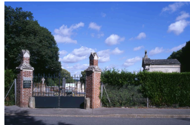
Le portail d'entr e, rue Lescouv . Phot. Marie-Laure Monnehay-Vulliet IVR22_20078000203XA
