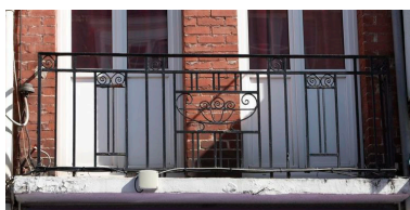
Ferronnerie ornée de spirales. Phot. Pierre Thibaut IVR31_20096200238NUCA
