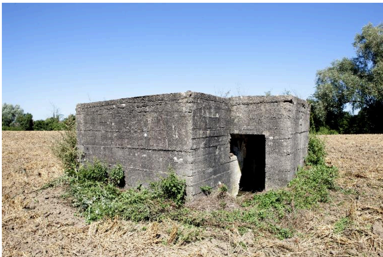
vue de trois-quarts, vers le nord
