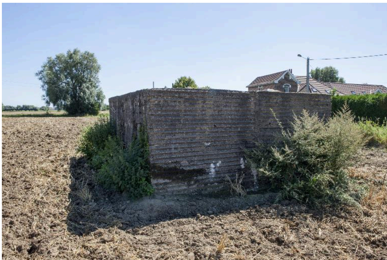
Vue de trois-quarts, vers le sud
