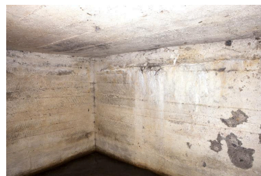
Vue intérieure, depuis l'entrée Phot. Pierre Thibaut IVR32_20165901344NUCA
