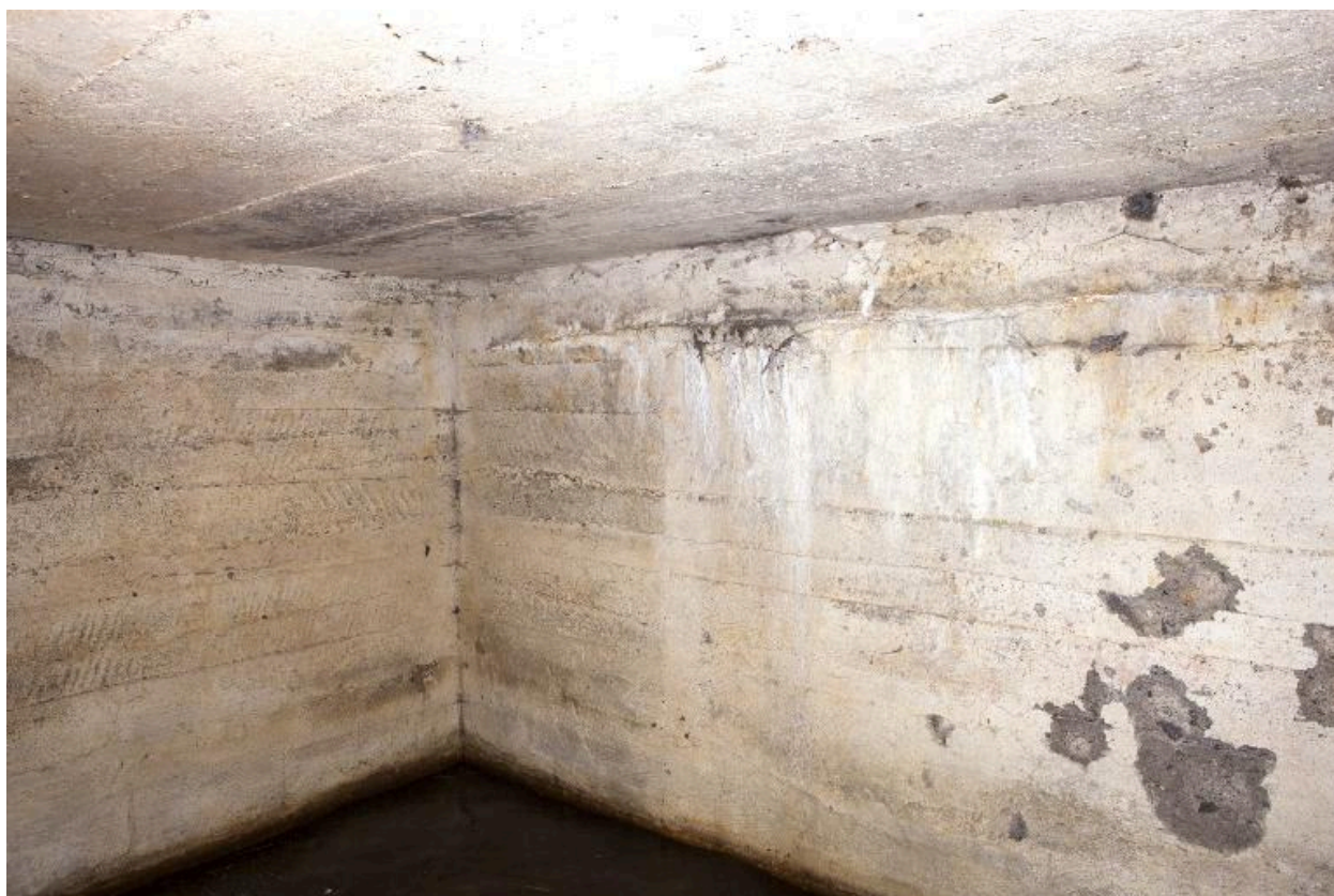
Vue intérieure, depuis l'entrée
