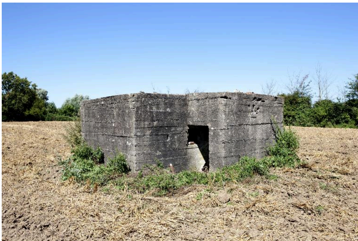
vue de trois-quarts, vers le nord
