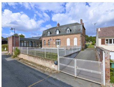
Vue de l'école, depuis le sud. Phot. Thierry Lefébure IVR32_20248001345NUCA
