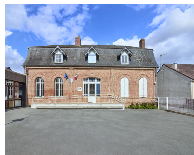
Vue de l'école, depuis le sud/ouest. Phot. Thierry Lefébure IVR32_20248001346NUCA
