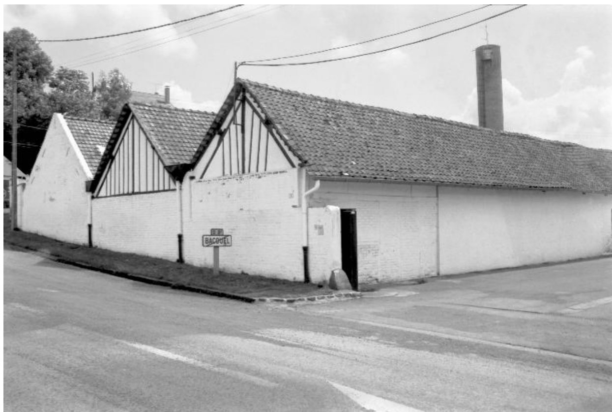
Détail flanc nord ouest.
