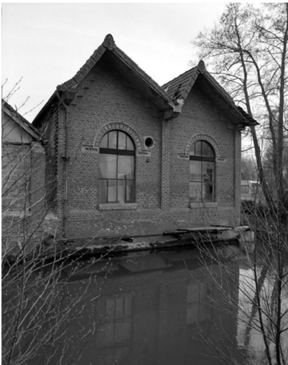
Vue partielle de l'atelier de fabrication.
