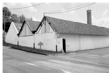
Détail flanc nord ouest. Phot. Benoît Dufournier IVR22_19878000106Z
