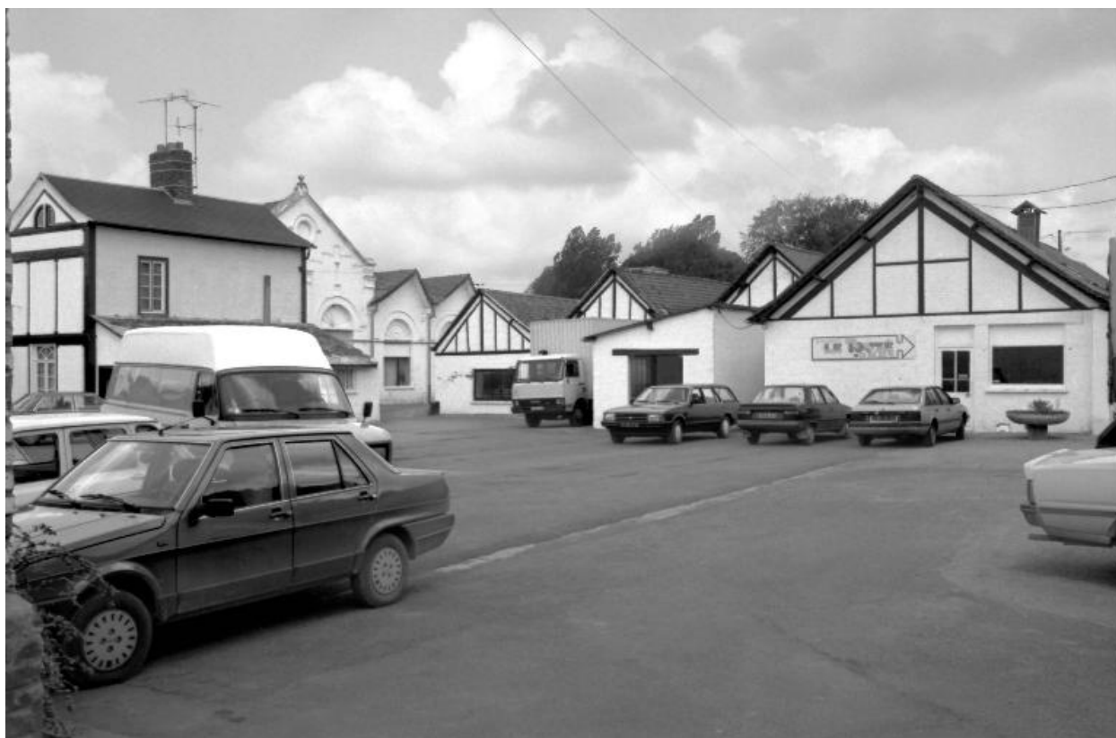
Ateliers de fabrication et bureaux.
