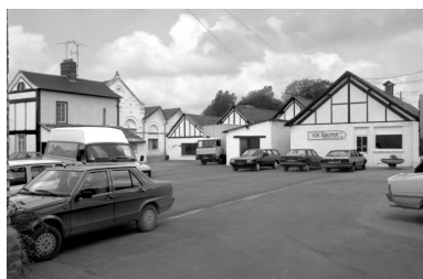
Ateliers de fabrication et bureaux. Phot. Benoît Dufournier IVR22_19878000110Z
