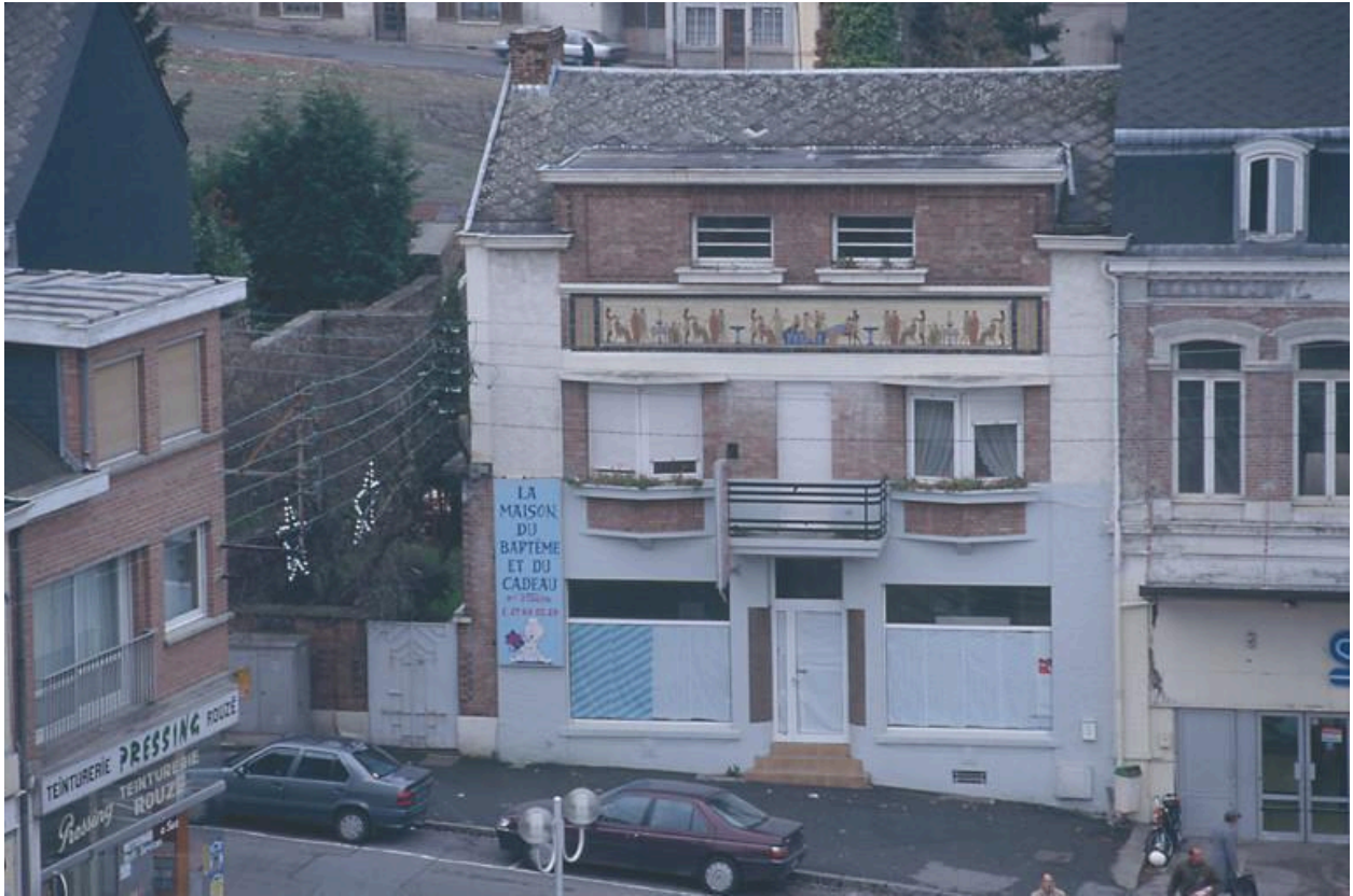
Vue générale de la façade.
