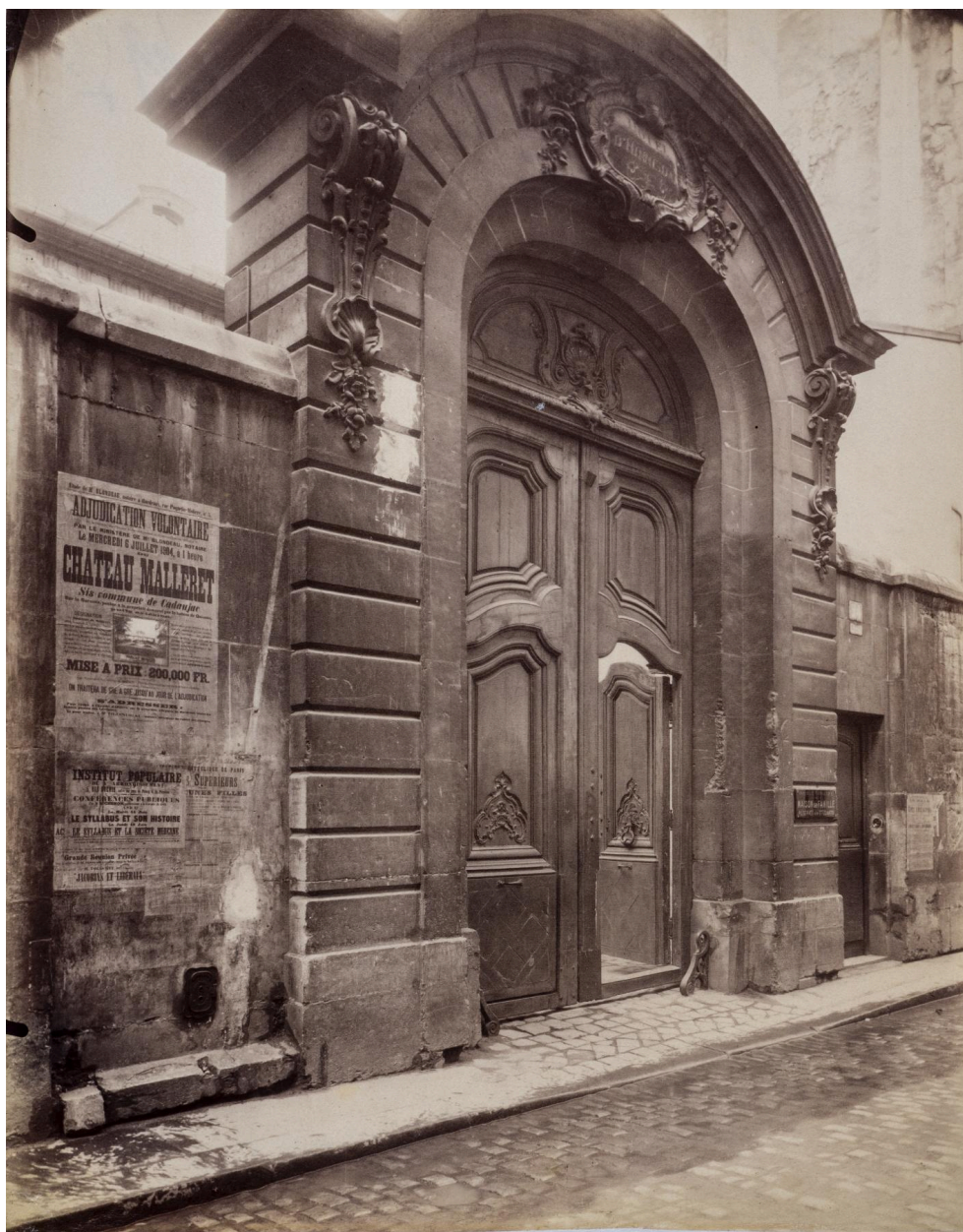
Portail de l'hôtel d'Hinnisdal, rue Cassette à Paris. Photographie d'Eugène Atget (1857-1927), juin 1904 (AP Château de Regnière-Écluse, non coté).
