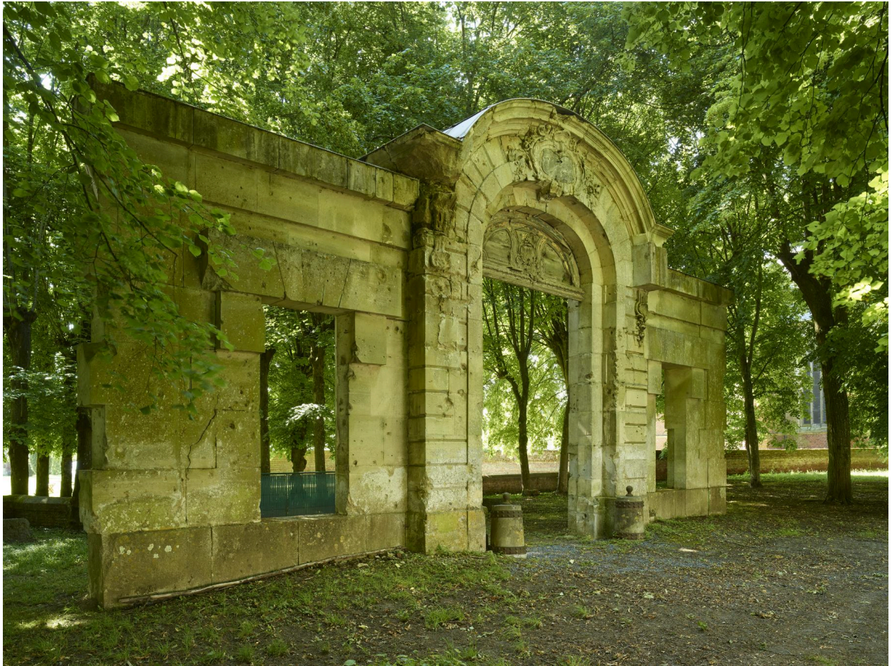
Vue de côté du portail de l'hôtel d'Hinnisdal, jadis côté rue Cassette (prise depuis le nord-ouest).
