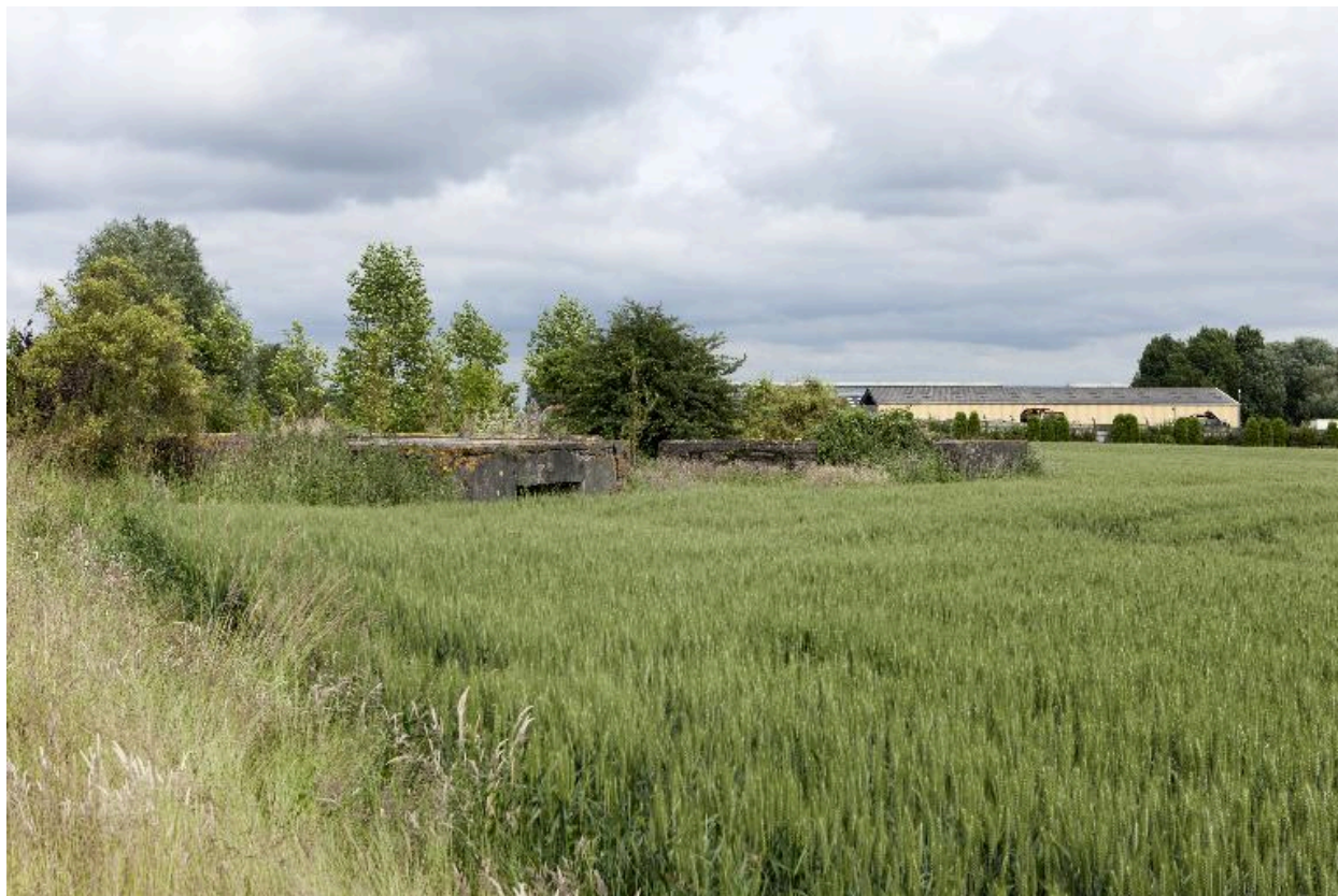
Vue générale vers le nord-est
