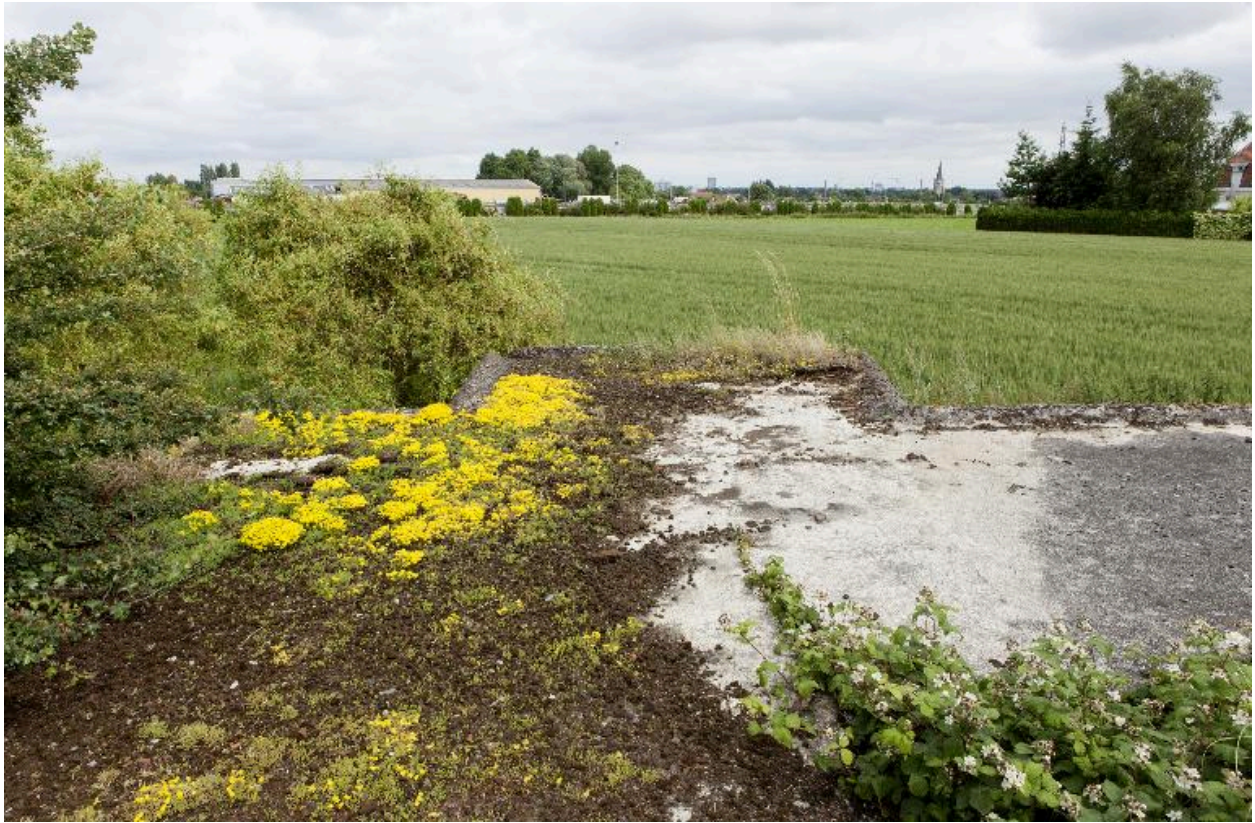
Couvrement vers le nord-ouest de la casemate est
