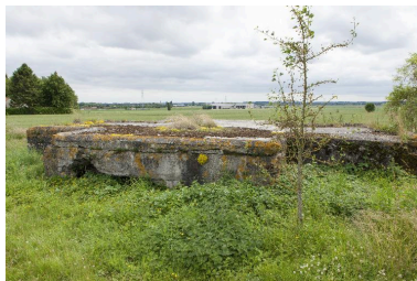
Vue antérieure de la casemate ouest Phot. Jean-Marc Ramette IVR31_20145904821NUCA
