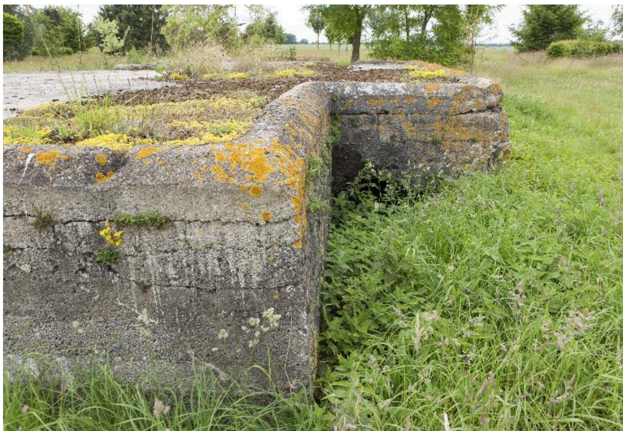
Angle nord-est de la casemate ouest
