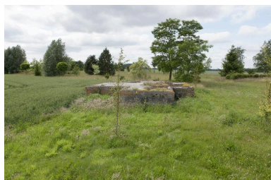
Vue latérale, vers le nord-ouest, de la casemate ouest Phot. Jean-Marc Ramette IVR31_20145904822NUCA
