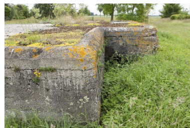
Angle nord-est de la casemate ouest Phot. Jean-Marc Ramette IVR31_20145904824NUCA
