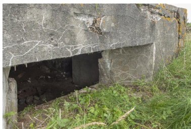
Elévation nord de la casemate ouest. Sortie du canon ? Phot. Jean-Marc Ramette IVR31_20145904823NUCA
