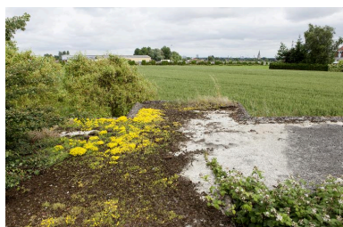
Couvreur vers le nord-ouest de la casemate est Phot. Jean-Marc Ramette IVR31_20145904825NUCA
