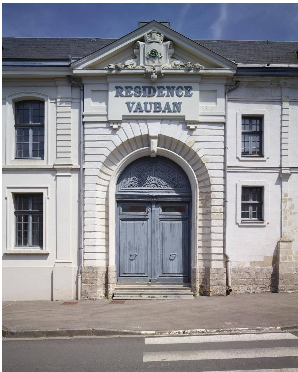
Ancien hôpital, actuelle résidence Vauban : vue de la porte du XIXe siècle depuis la rue Thiers.
