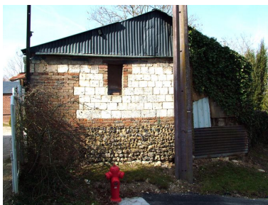
Pignon sur rue de l'ancienne étable. Phot. Frédéric Fournis IVR22_20108001101NUCA
