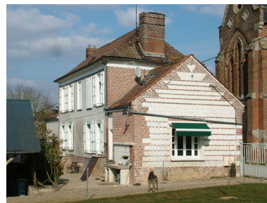
Vue de trois quarts arrière du logis. Phot. Frédéric Fournis IVR22_20108001099NUCA
