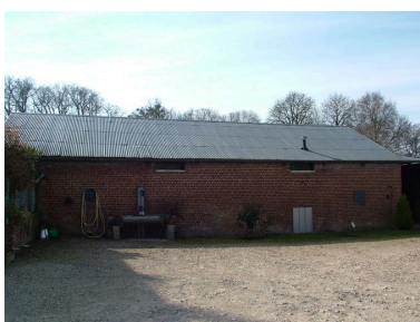
Nouvelle étable. Phot. Frédéric Fournis IVR22_20108001105NUCA
