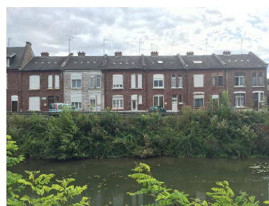
Les logements de la cité de la Clouterie, façade donnant sur le canal. Phot. Bertrand Fournier IVR22_20158006215NUCA
