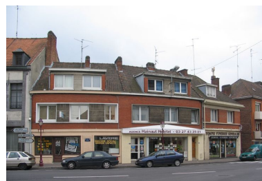
Rang sud-ouest, vue partielle : n° 39 à 45. Phot. François Bisman IVR31_20065906236NUCA
