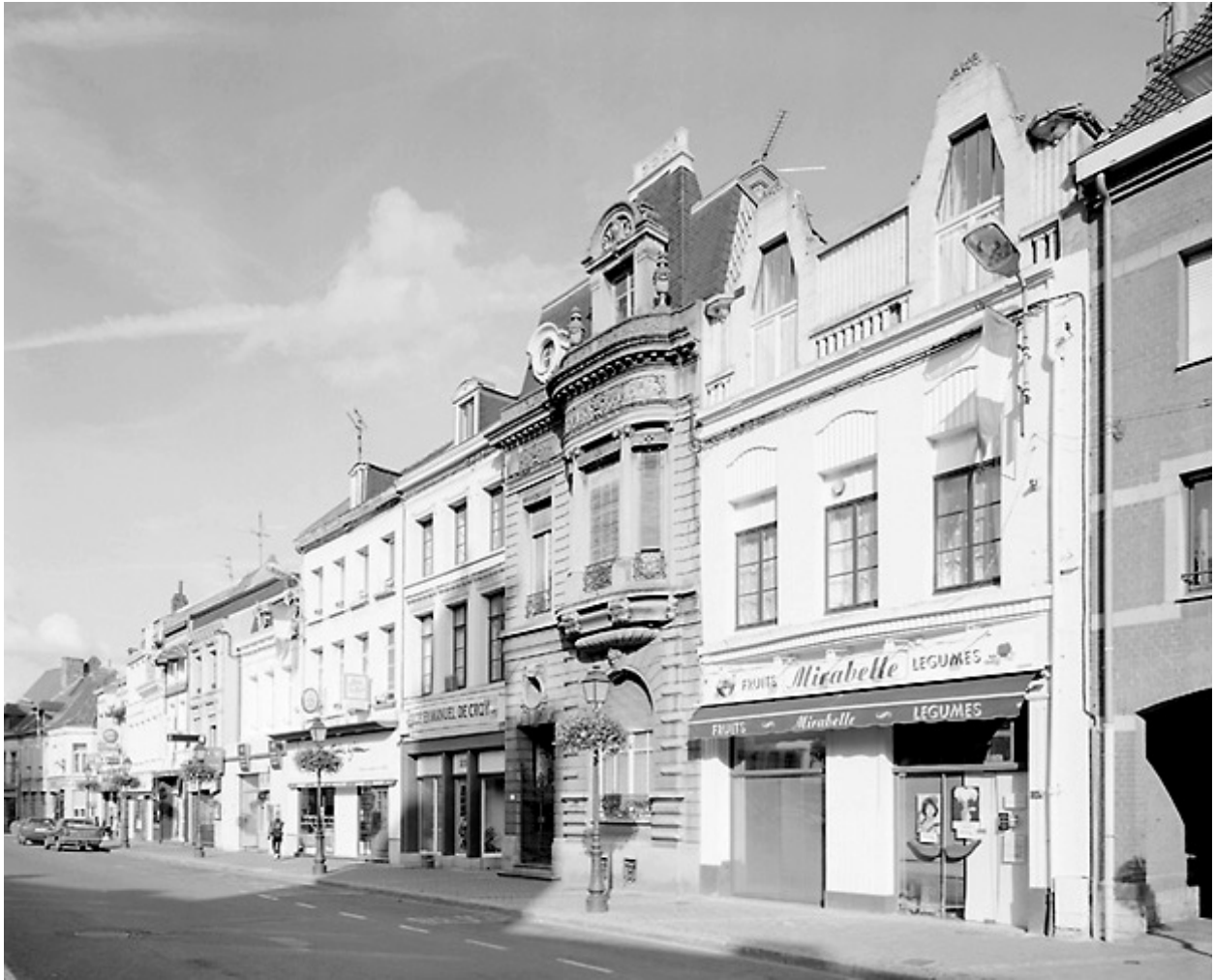
Rang sud-est, vue partielle : n° 3 à 27 (vue en 2001).
