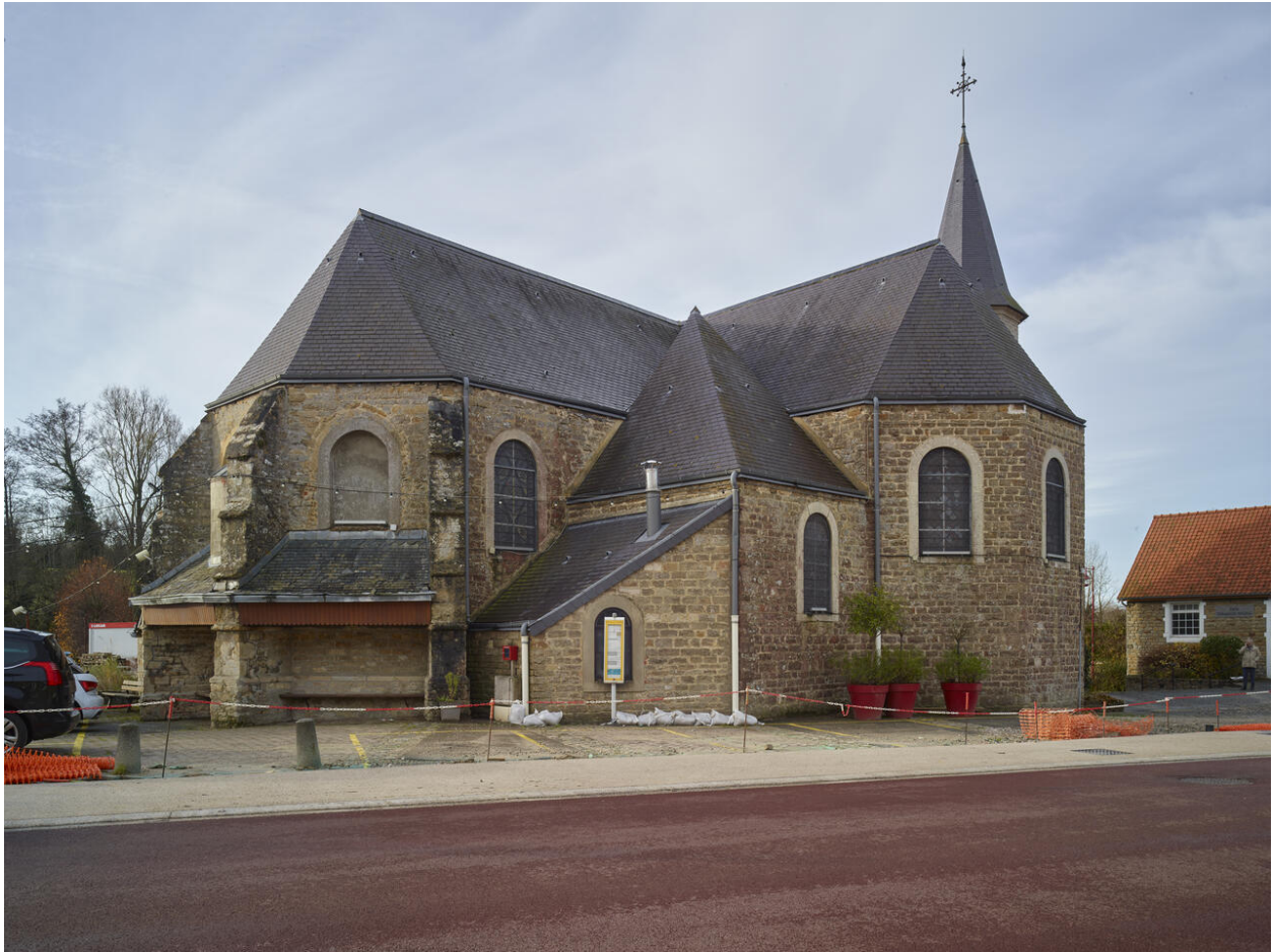
Vue de l'élévation nord.
