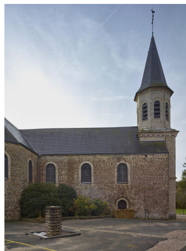
Vue du clocher depuis le nord. Phot. Pierre Thibaut IVR32_20236200970NUCA
