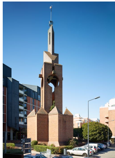
Vue générale. Phot. Pierre Thibaut IVR31_20155901727NUCA
