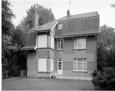
Elévation postérieure. Phot. Thierry Petitberghien IVR31_20015902284V
