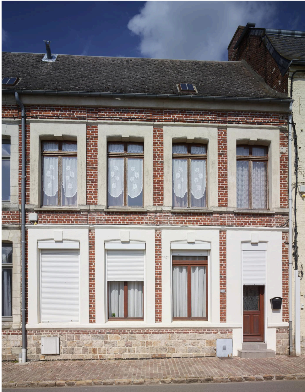
Détail de la façade du n°20, rue du Général-Bouttiaux.
