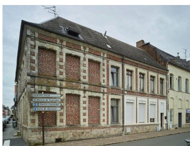
Façade rue du Général-Bouttiaux. Phot. Pierre Thibaut IVR32_20245900366NUCA
