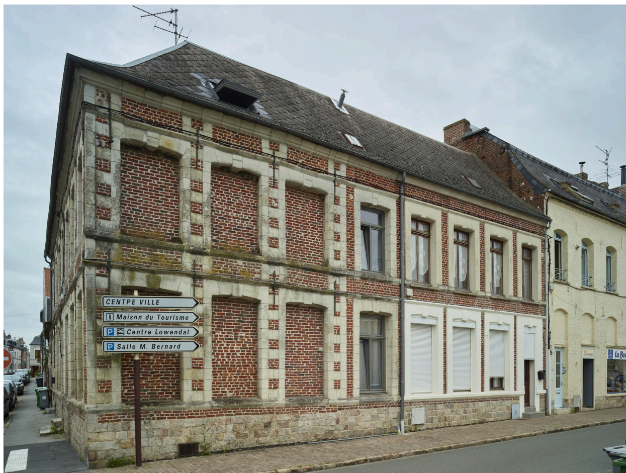
Façade rue du Général-Bouttiaux.
