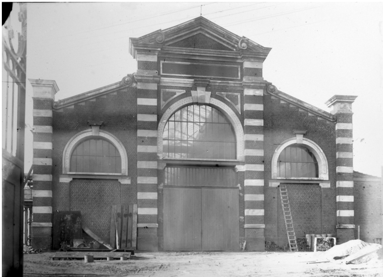
Saint-Quentin, façade d'atelier de fonderie de l'usine de construction mécanique Gauger, vers 1919 (AD Aisne)
