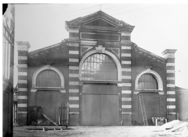
Saint-Quentin, façade d'atelier de fonderie de l'usine de construction mécanique Gauger, vers 1919 (AD Aisne) Phot. Pillet Frédéric IVR22_20060205377NUCAB
