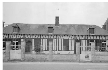
Elévation antérieure. Phot. Jean-Michel Perrin IVR22_19846001063X
