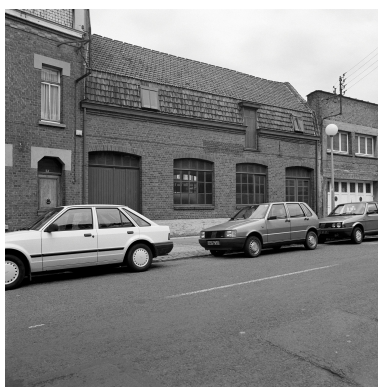
Atelier de fabrication rue Jules-Lebleu. Phot. Philippe Dapvril IVR31_19885901355X
