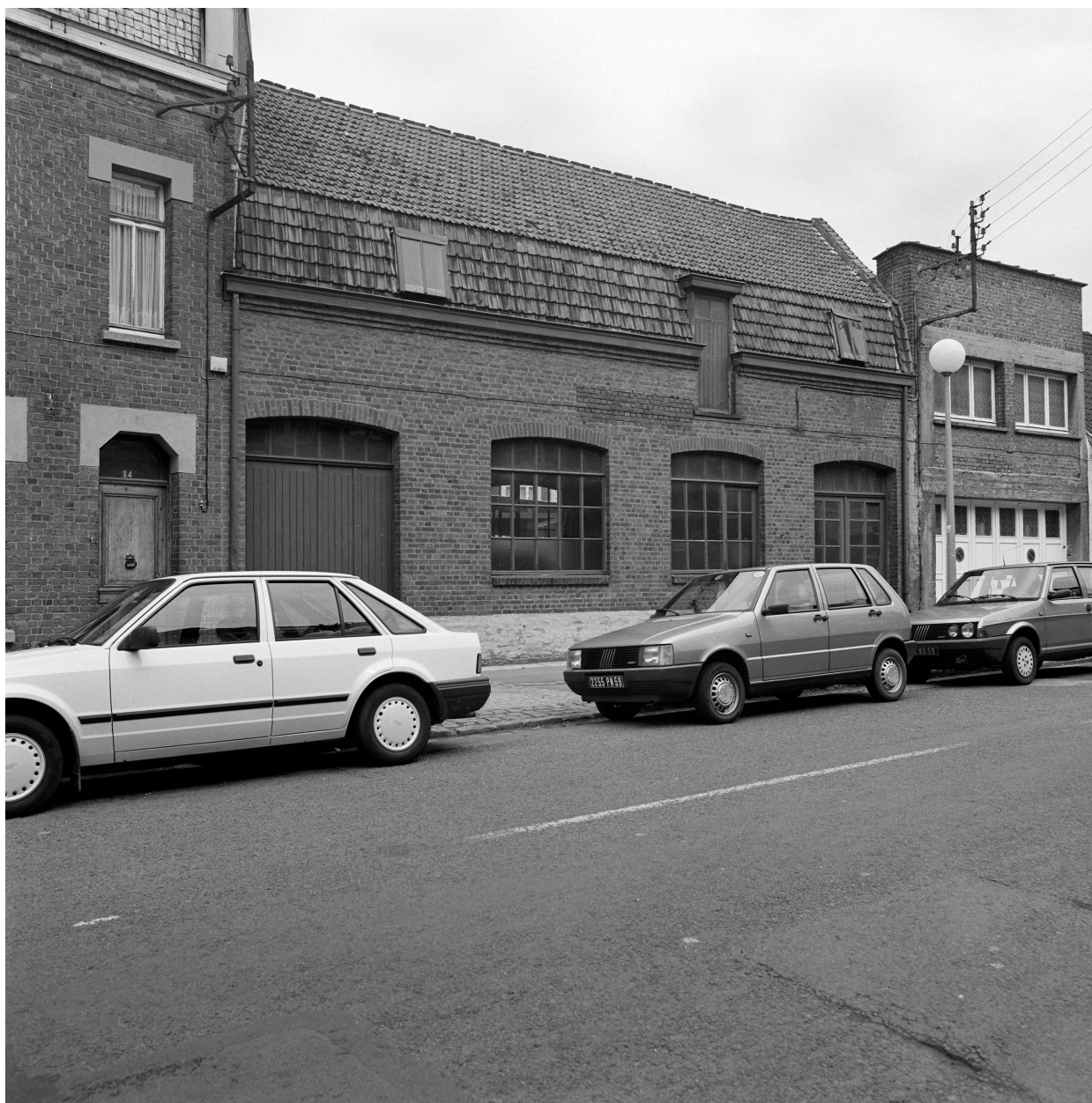
Atelier de fabrication rue Jules-Lebleu.
