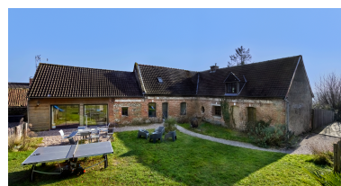
Vue nord de la maison depuis la cour, porte la date 1810. Phot. Thierry Lefébure IVR32_20258000127NUCA
