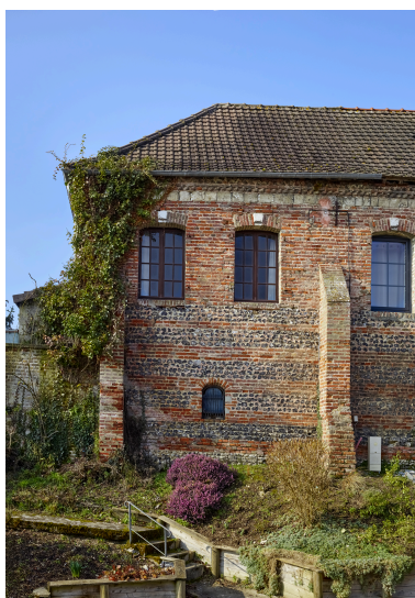
Détail de l'élévation du bâtiment sur rue de l'ancienne ferme, depuis l'est. Phot. Thierry Lefébure IVR32_20258000125NUCA
