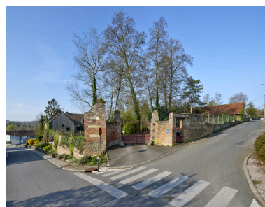
Vue de l'entrée de la ferme, depuis le nord. Phot. Thierry Lefébure IVR32_20258001499NUCA
