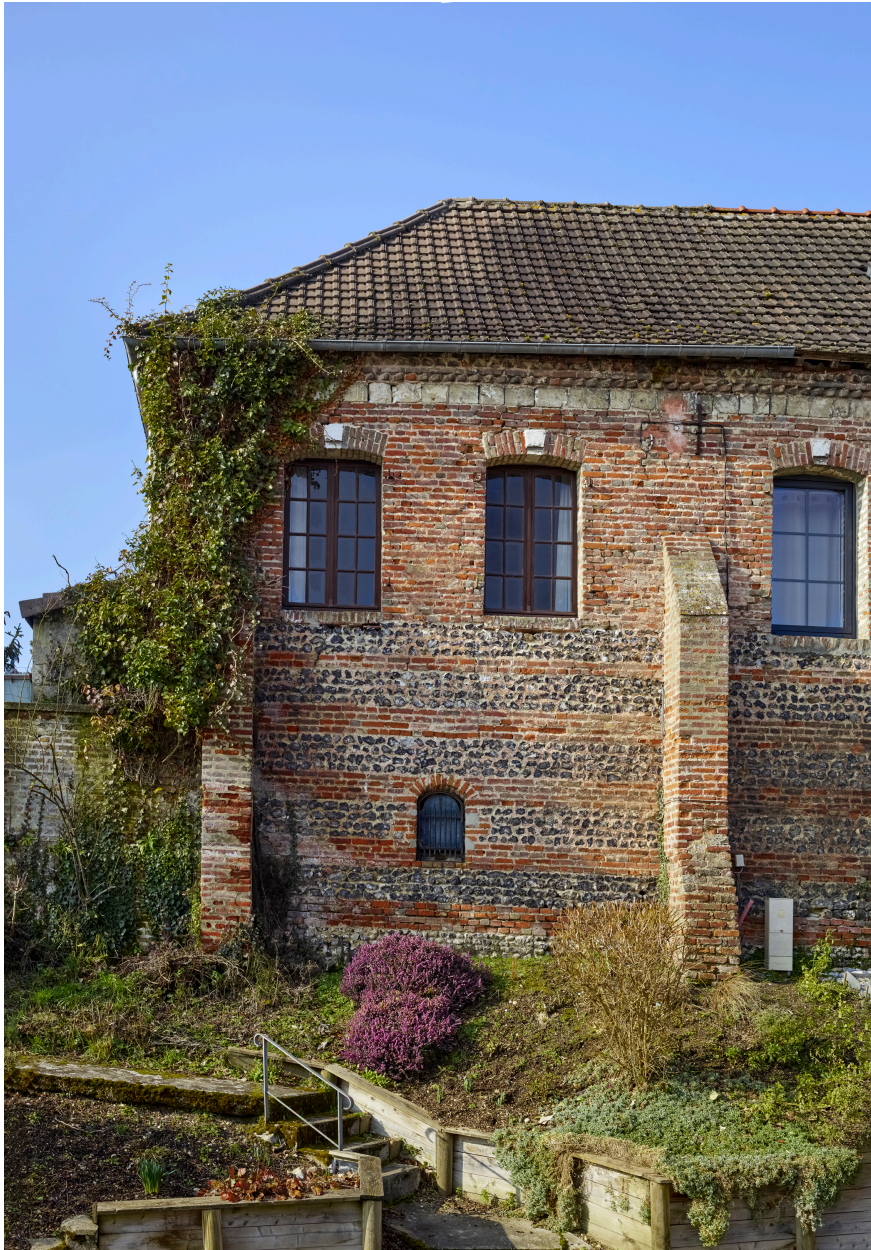
Détail de l'élévation du bâtiment sur rue de l'ancienne ferme, depuis l'est.
