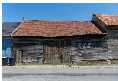
Grange sur rue avec entrée charretière, n°64 de la rue Marcel-Dassault, vue depuis le sud.
