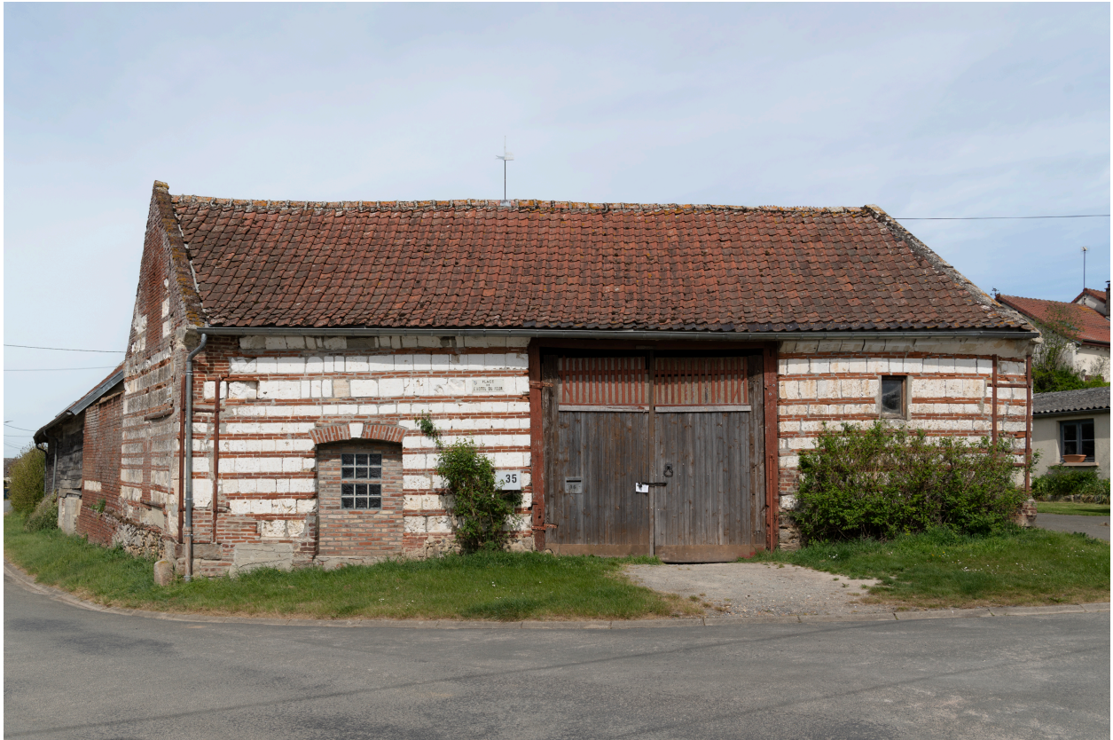
Ancienne grange sur rue avec un appareil en "rouges barres", n°35 de la rue de l'École, vue depuis l'est.
