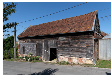
Grange avec entrée charretière et porte à engranger, n°26 de la rue de l'École, vue depuis l'est. Phot. Marc Kérignard IVR32_20256000360NUCA
