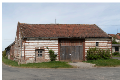
Ancienne grange sur rue avec un appareil en "rouges barres", n°35 de la rue de l'École, vue depuis l'est. Phot. Marc Kérignard IVR32_20266000127NUCA
