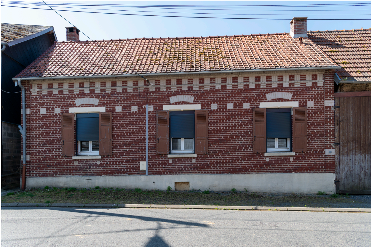
Logis sur rue de la Première Reconstruction, n°82 de la rue Casimir-Maumené, vue depuis le nord.
