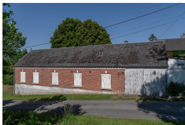
Logis sur rue de la Première Reconstruction (?), n°22 de la rue de l'École, vue depuis l'est. Phot. Marc Kérignard IVR32_20256000361NUCA
