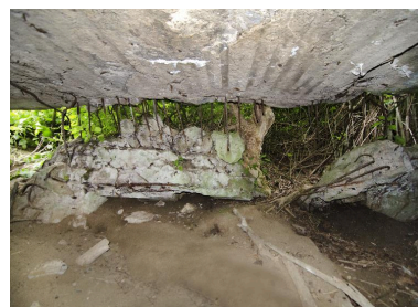
Le mur sud, exposé, de l'intérieur Phot. Jean-Marc Ramette IVR32_20165901170NUCA
