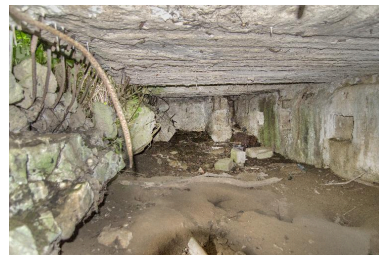
Salle principale, exposée au sud. Dans le fond, le départ de la coursière de tir Phot. Jean-Marc Ramette IVR32_20165901165NUCA
