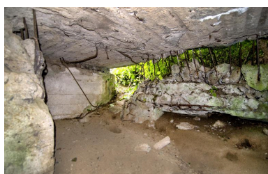
Vue intérieure vers la sortie sud-est Phot. Jean-Marc Ramette IVR32_20165901169NUCA
