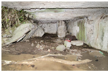
Salle principale, exposée au sud. Dans le fond, le départ de la coursière de tir Phot. Jean-Marc Ramette IVR32_20165901166NUCA
