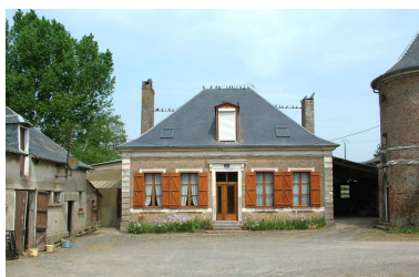
Vue de la cour avec étable, logis et colombier.
