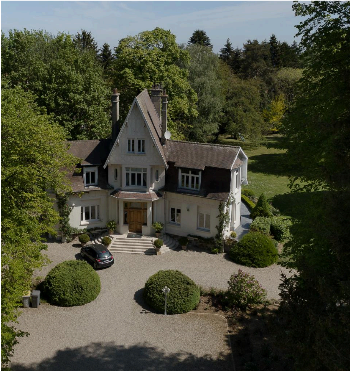
Vue aérienne des façades ouest deuis la rue du faubourg de Péronne.
