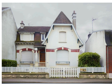
Maison particulière, 31 rue du Faubourg de Péronne. Propriété de M. Prosper Bouchez. Architecte Paul Auger. Phot. Hubert Bouvet IVR32_20196200865NUCA
