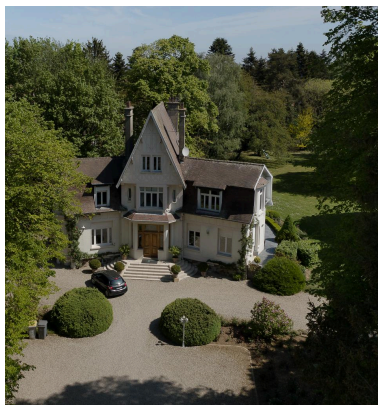
Vue aérienne des façades ouest deuis la rue du faubourg de Péronne. Phot. Marc Kérignard IVR32_20226200047NUCA
