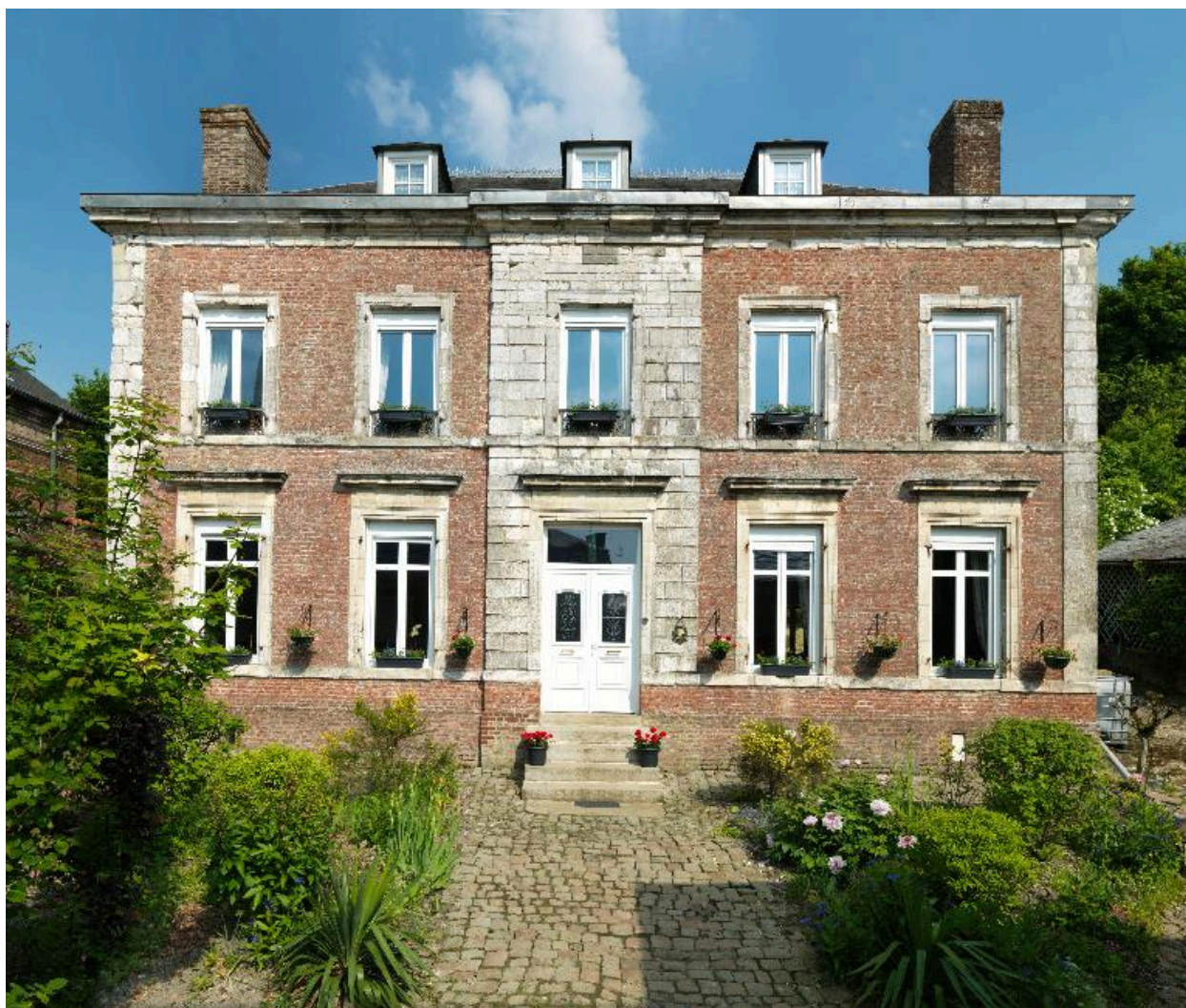
Façade sur cour.
