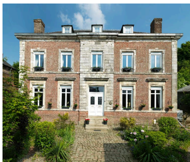
Façade sur cour. Phot. Thierry Lefébure IVR22_20138000195NUC2AQ
