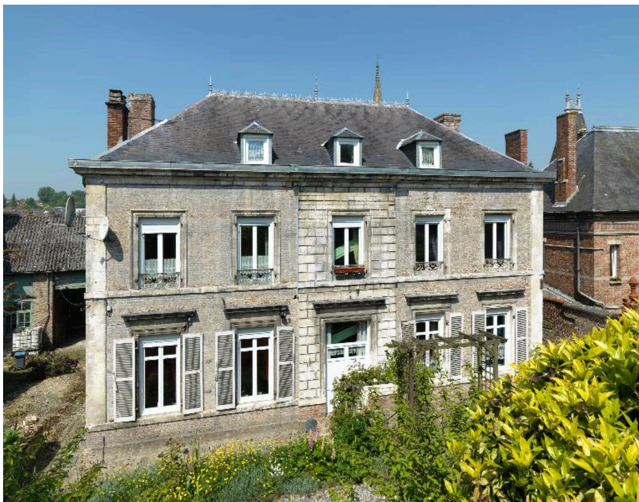
Façade postérieure, vue de face.
