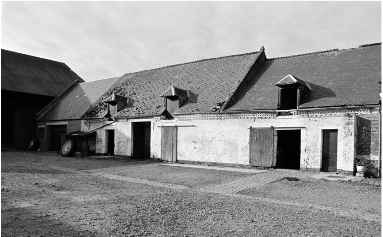
Vue de l'élévation sur cour des étables nord.
