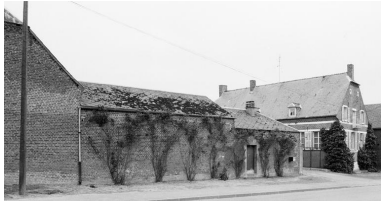
Vue d'ensemble des élévations sur rue. Phot. Thierry Lefébure IVR22_19920201193Z
