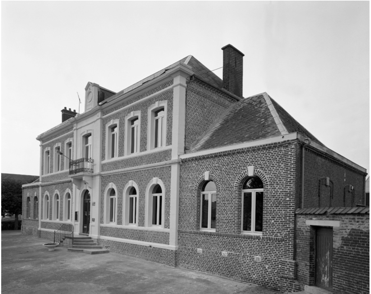
Vue d'ensemble de la façade.
