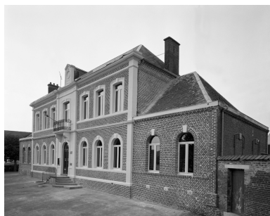
Vue d'ensemble de la façade. Phot. Thierry Lefébure IVR22_19910201976V
