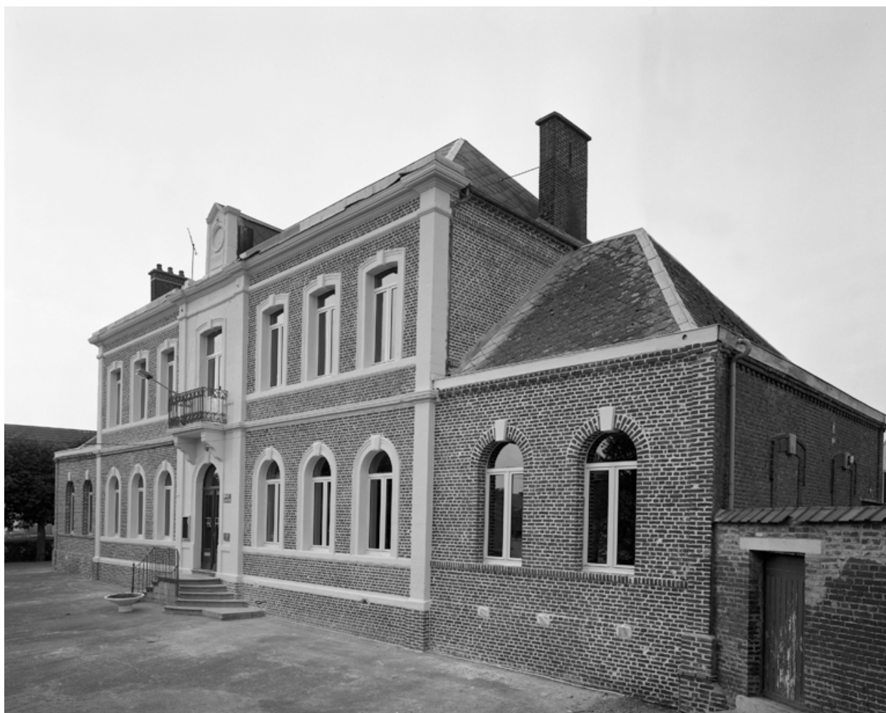
Vue d'ensemble de la façade.
