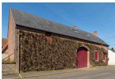
Ancienne grange, n°36 de la rue de la Vallée Saint-André, vue prise depuis l'est. Phot. Marc Kérignard IVR32_20236000539NUCA
