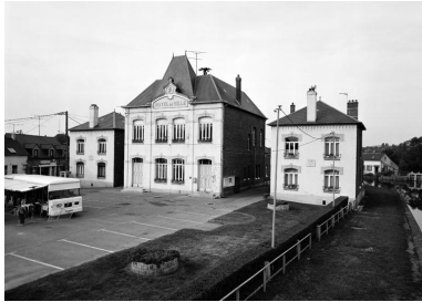
Vue d'ensemble de la façade. Phot. Thierry Lefébure IVR22_19910201966V
