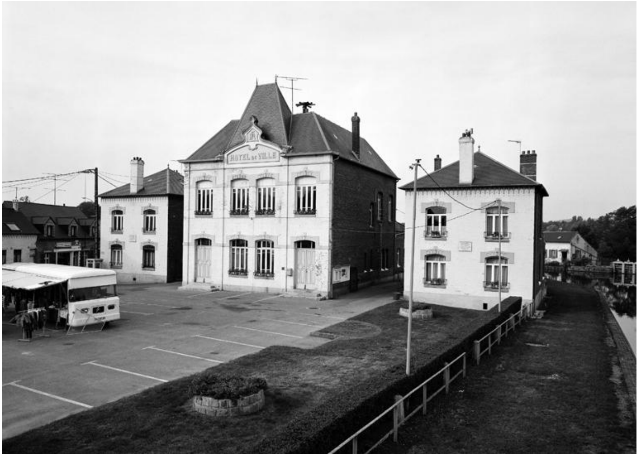
Vue d'ensemble de la façade.
