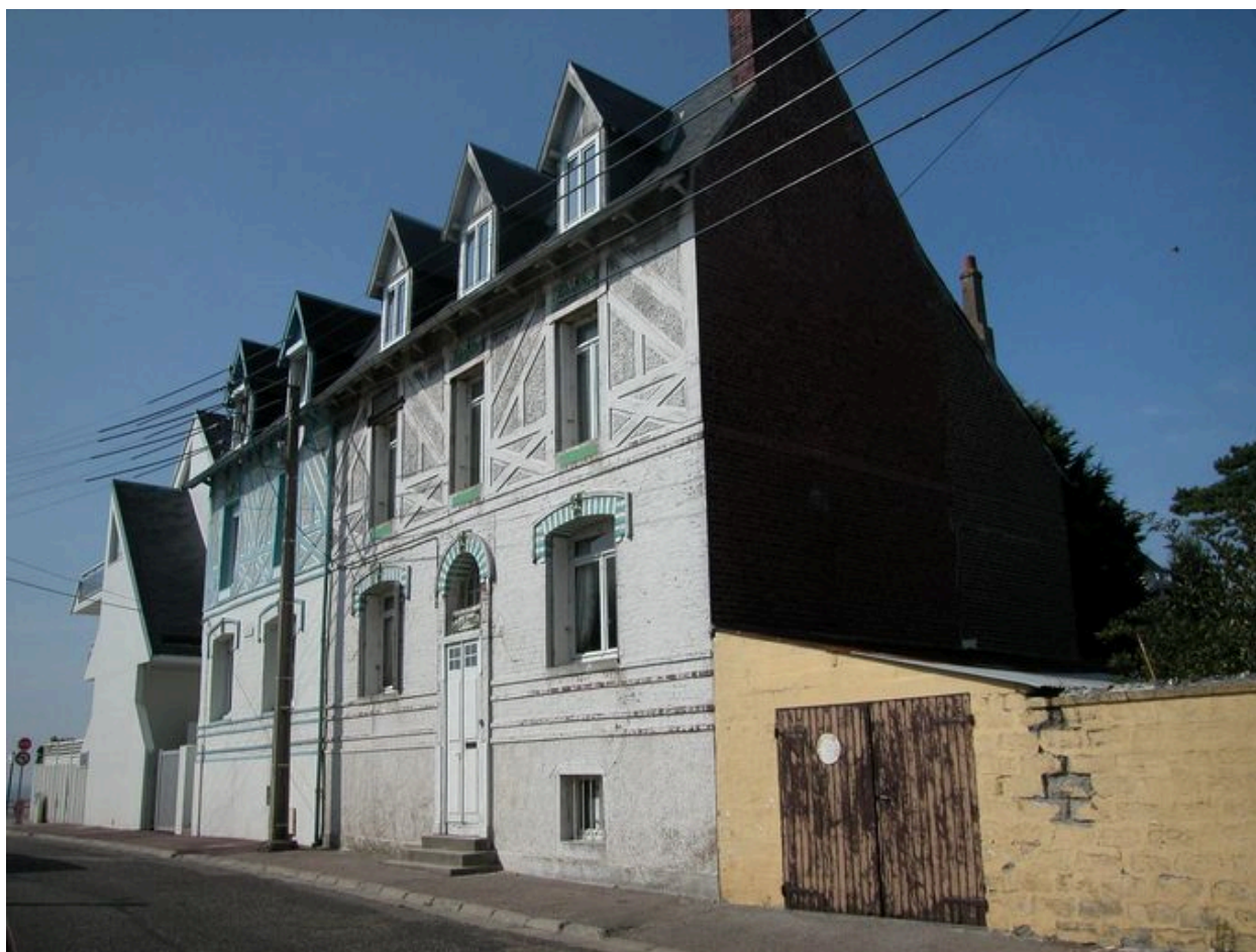
Vue d'ensemble depuis l'allée Beaurivage, avec la maison dite Les Events au premier plan.
