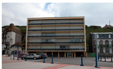
Vue de l'immeuble à appartements construit à l'emplacement de la Villa Barni. Phot. Elisabeth Justome IVR22_20058002564NUCA
