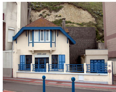
Vue de la maison dite Entre nous, anciens communs de la Villa Barni, rénovés. Phot. Elisabeth Justome IVR22_20058002563NUCA
