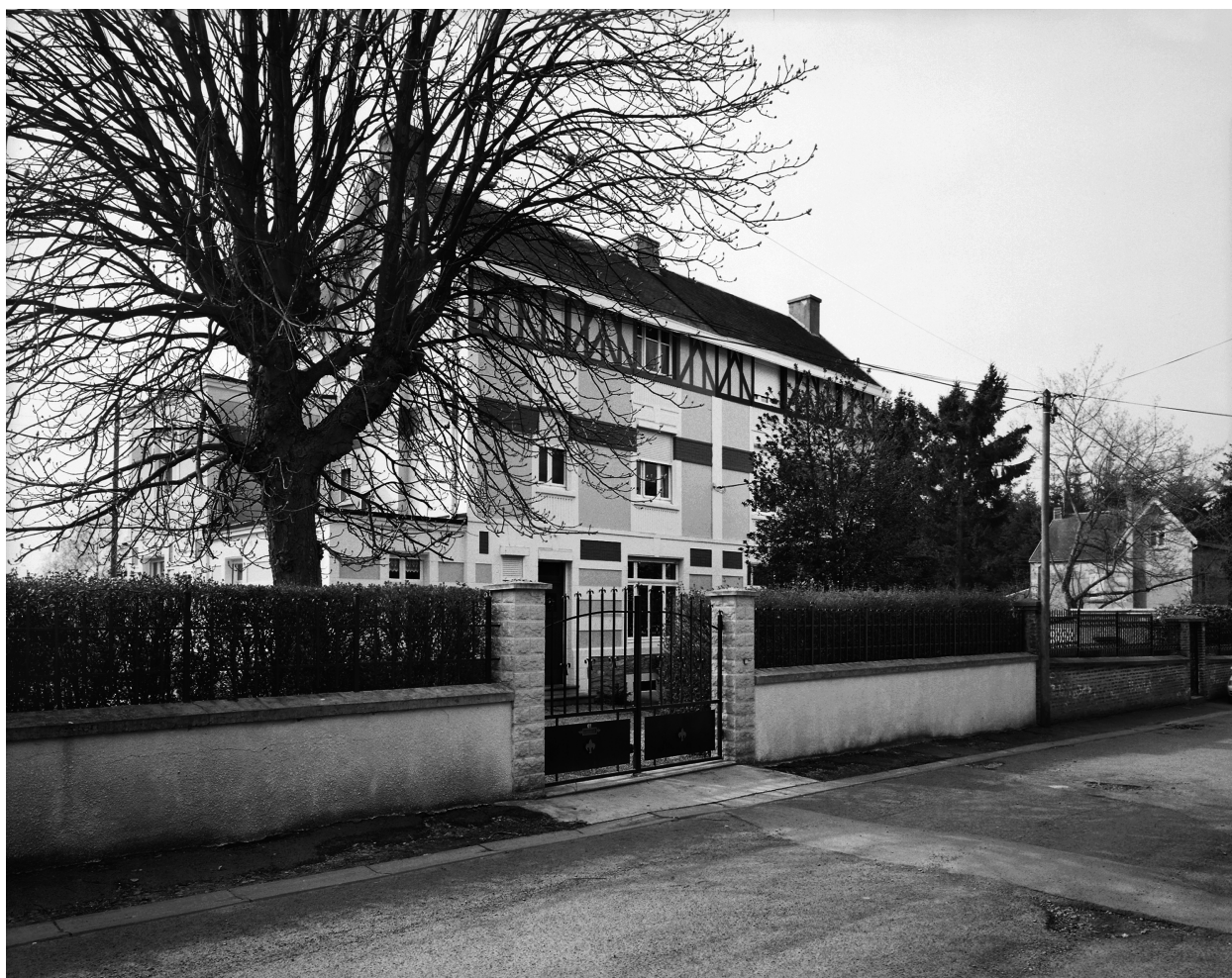
Vue générale d'un module.
