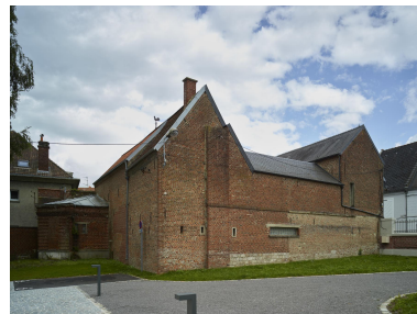
Façade latérale gauche depuis la cour du n°18, rue Carlier. Vue orientée sud-ouest/nord-est. Phot. Pierre Thibaut IVR32_20245900306NUCA
