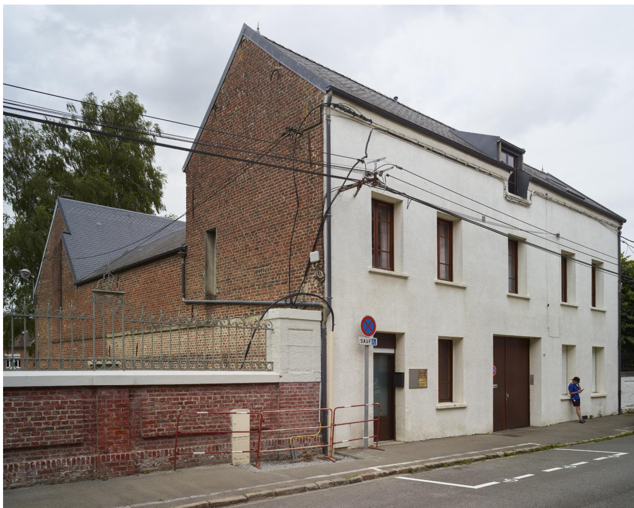
Bâtiment sur rue et façade latérale gauche. Vue orientée ouest/est.
