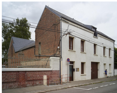
Bâtiment sur rue et façade latérale gauche. Vue orientée ouest/est.
