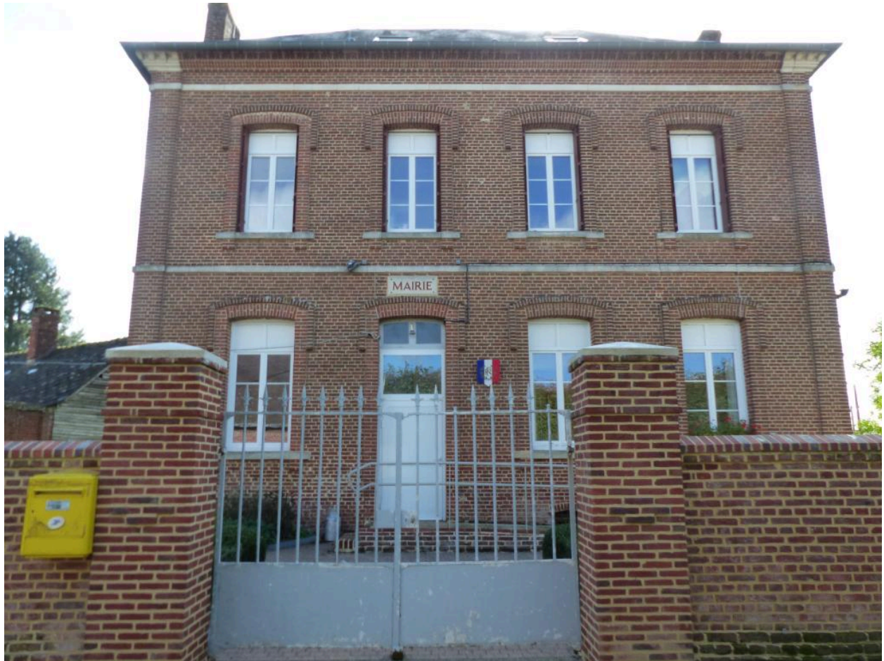
Façade sur rue de la mairie-école, n°34 Grande Rue, vue depuis le nord.
