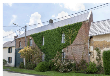
Ancienne boulangerie, n°24 rue Principale, vue depuis le nord-ouest.
