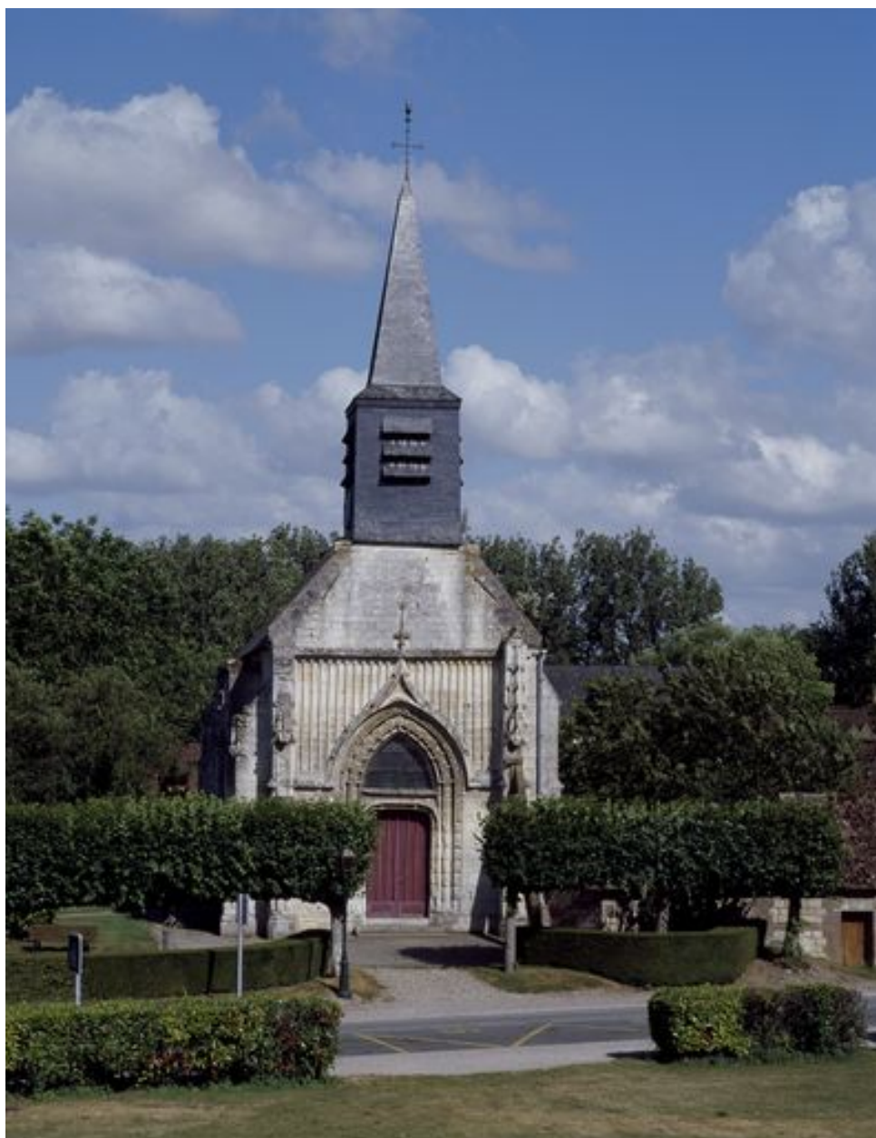
Vue de la façade occidentale.
