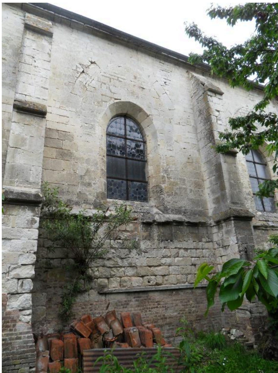
Baie du mur sud (deuxième travée).
