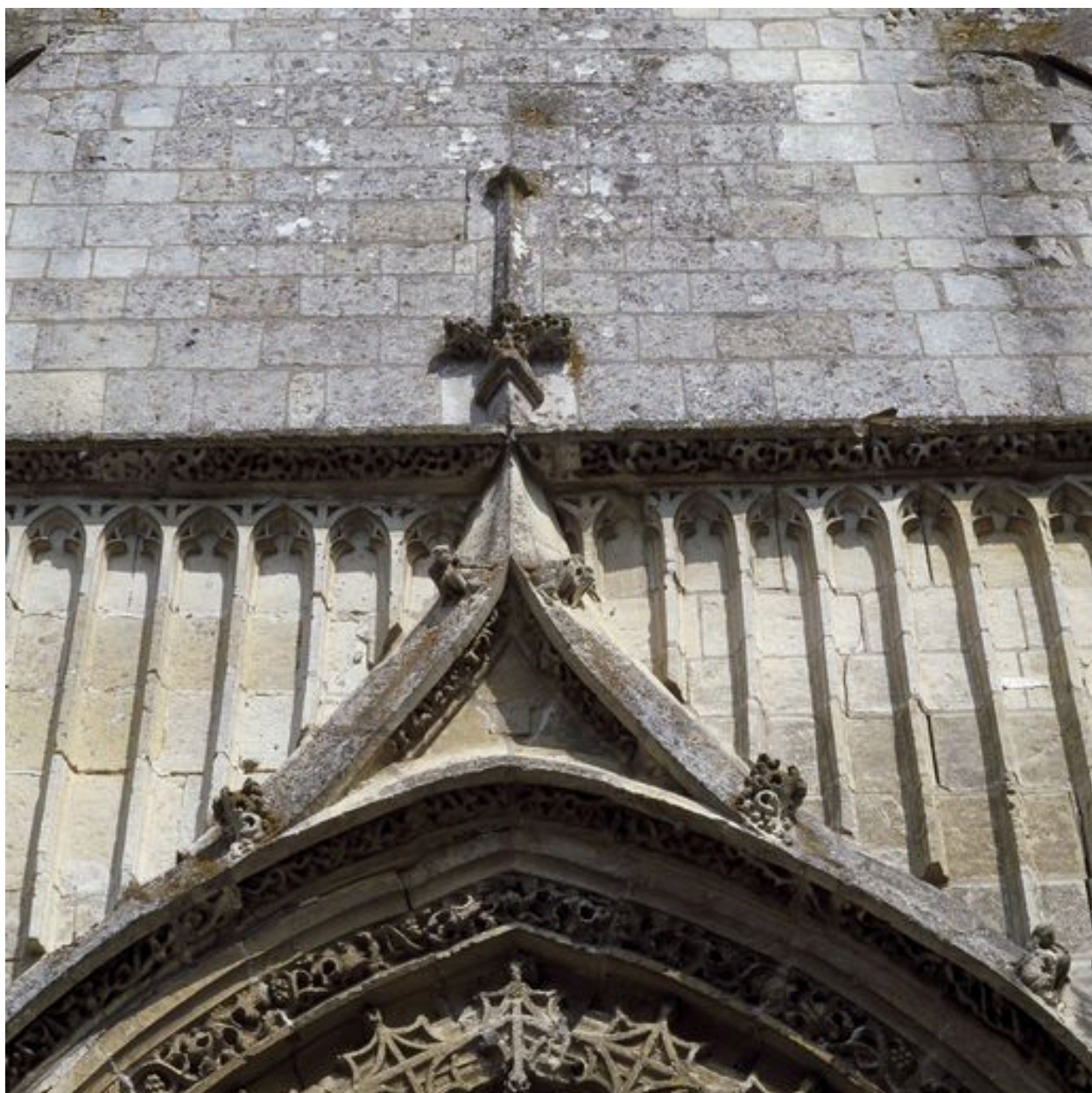
Détail de la façade occidentale.
