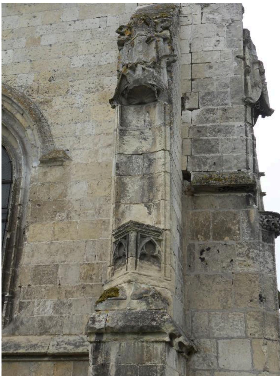
Détail sur le contrefort (angle nord-ouest)
