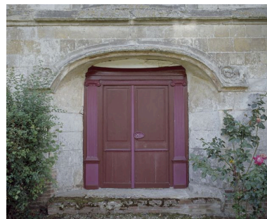
Portail nord. Phot. Marie-Laure Monnehay-Vulliet IVR22_20108000304XA
