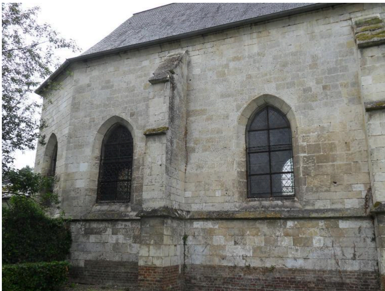
Mur nord du chœur.
