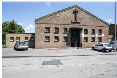
Élévation antérieure. Phot. Pierre Thibaut IVR31_20155900920NUCA
