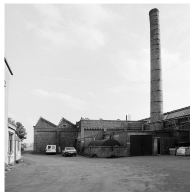
Atelier de fabrication depuis l'entrée. Phot. Olivier Marlard IVR31_19905901153X
