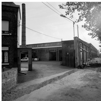
Entrée, élévation ouest. Phot. Olivier Marlard IVR31_19905901154X
