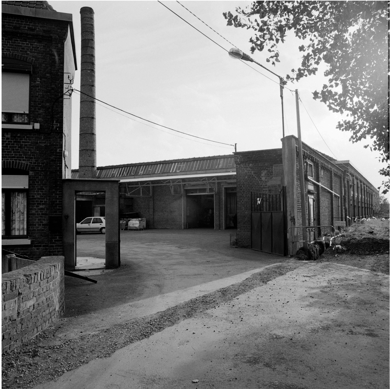
Entrée, élévation ouest.
