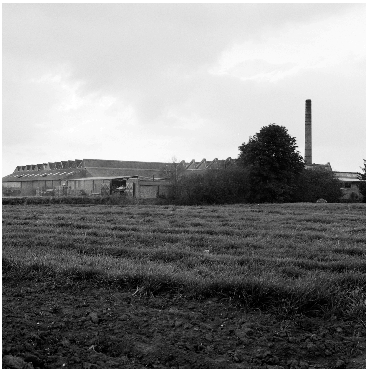
Vue générale vers le sud.
