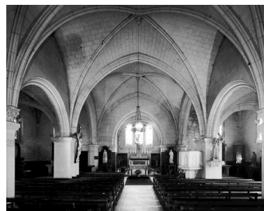
Vue intérieure vers le chœur. Phot. Jean-Michel Perrin IVR22_19846001368V
