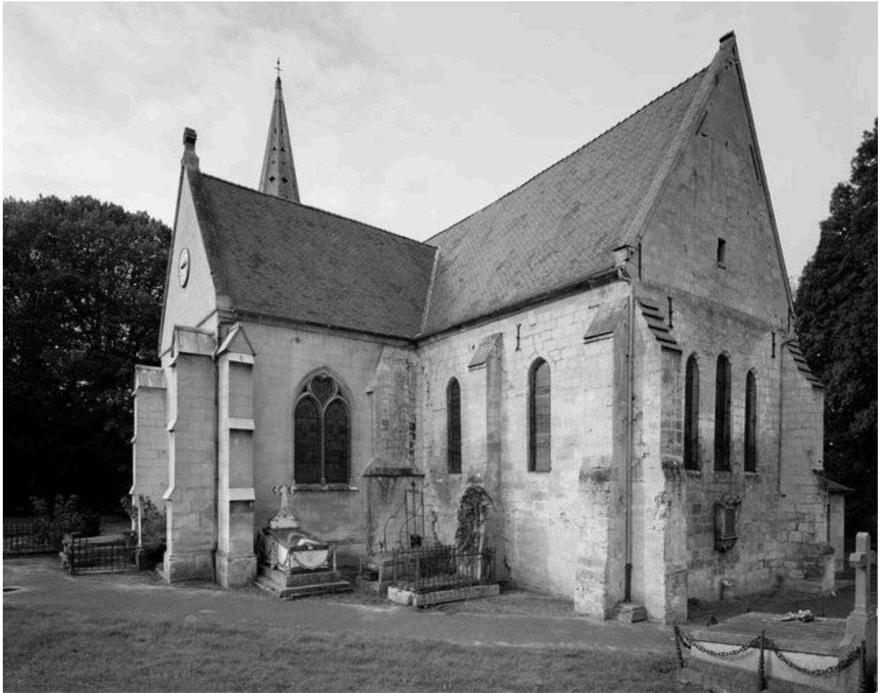
Transept et choeur depuis le sud-est.
