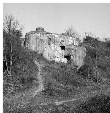
L'observatoire cuirassé, aile nord. Phot. Philippe Dapvril IVR31_20045900195X
