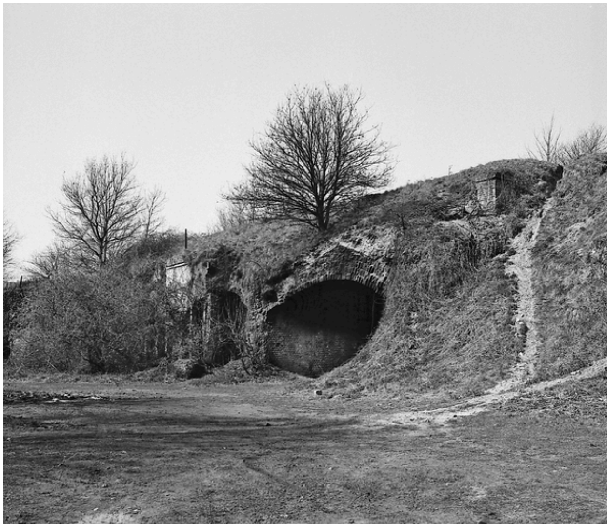
Vestiges du magasin à poudre nord.
