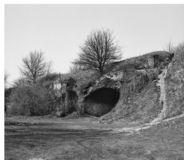
Vestiges du magasin à poudre nord. Phot. Philippe Dapvril IVR31_20045900194X
