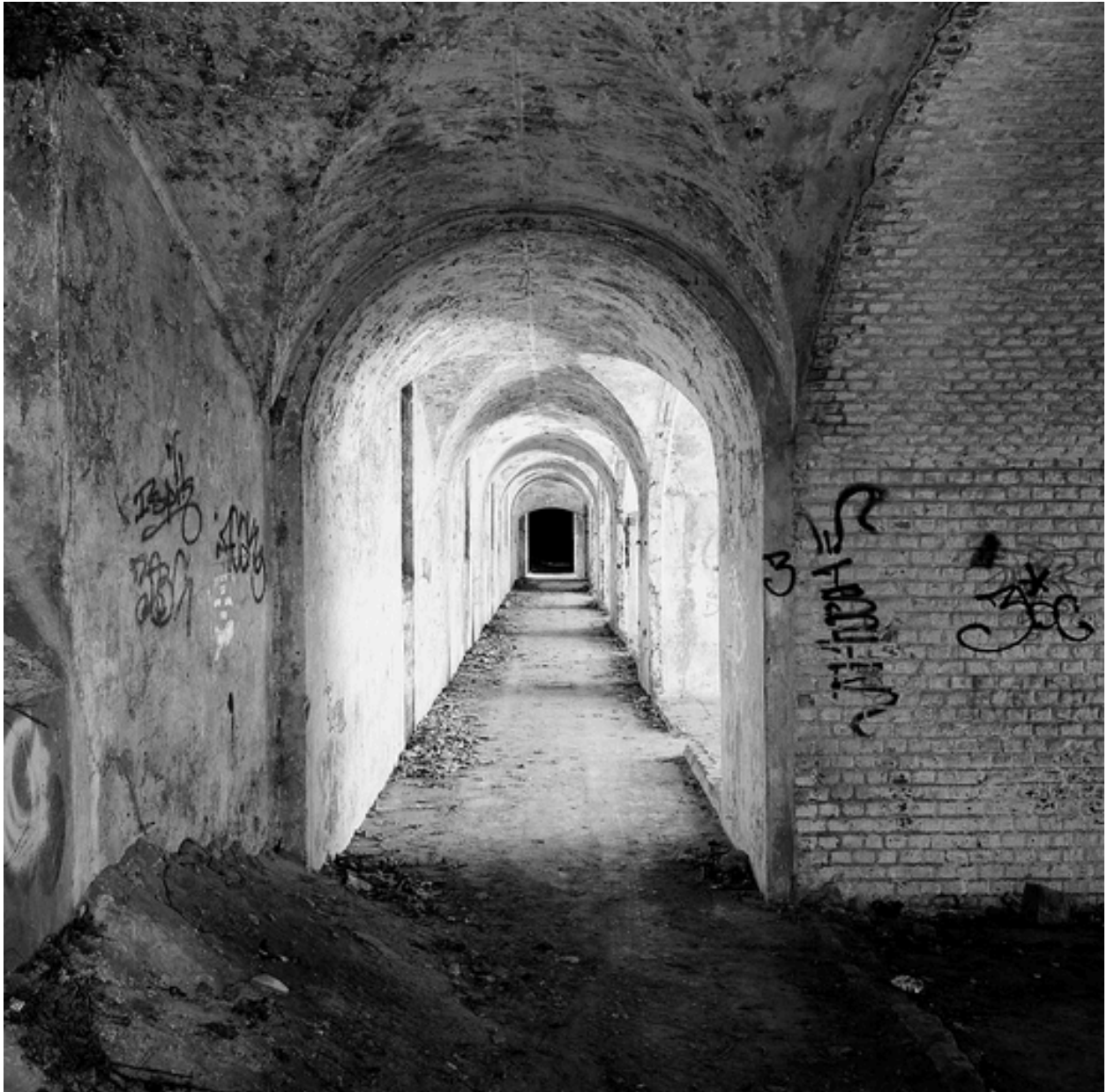
Casernement sud, le couloir desservant les salles.
