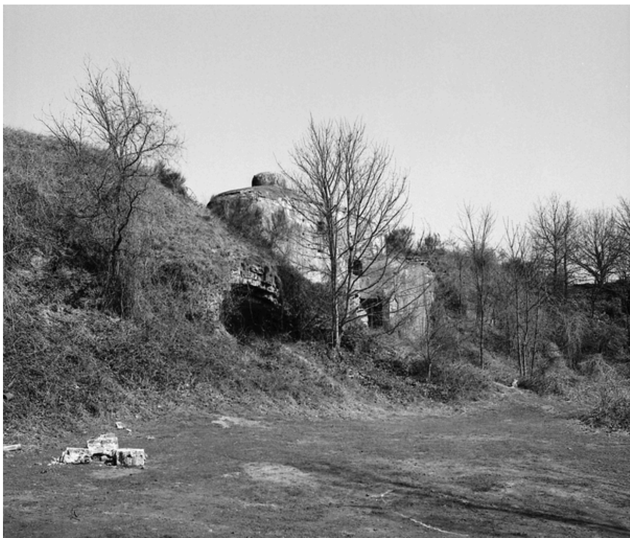
Vue générale de l'aile nord.
