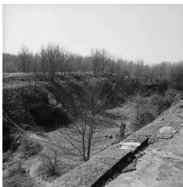
Vue générale, vers l'ouest. Phot. Philippe Dapvril IVR31_20045900192X
