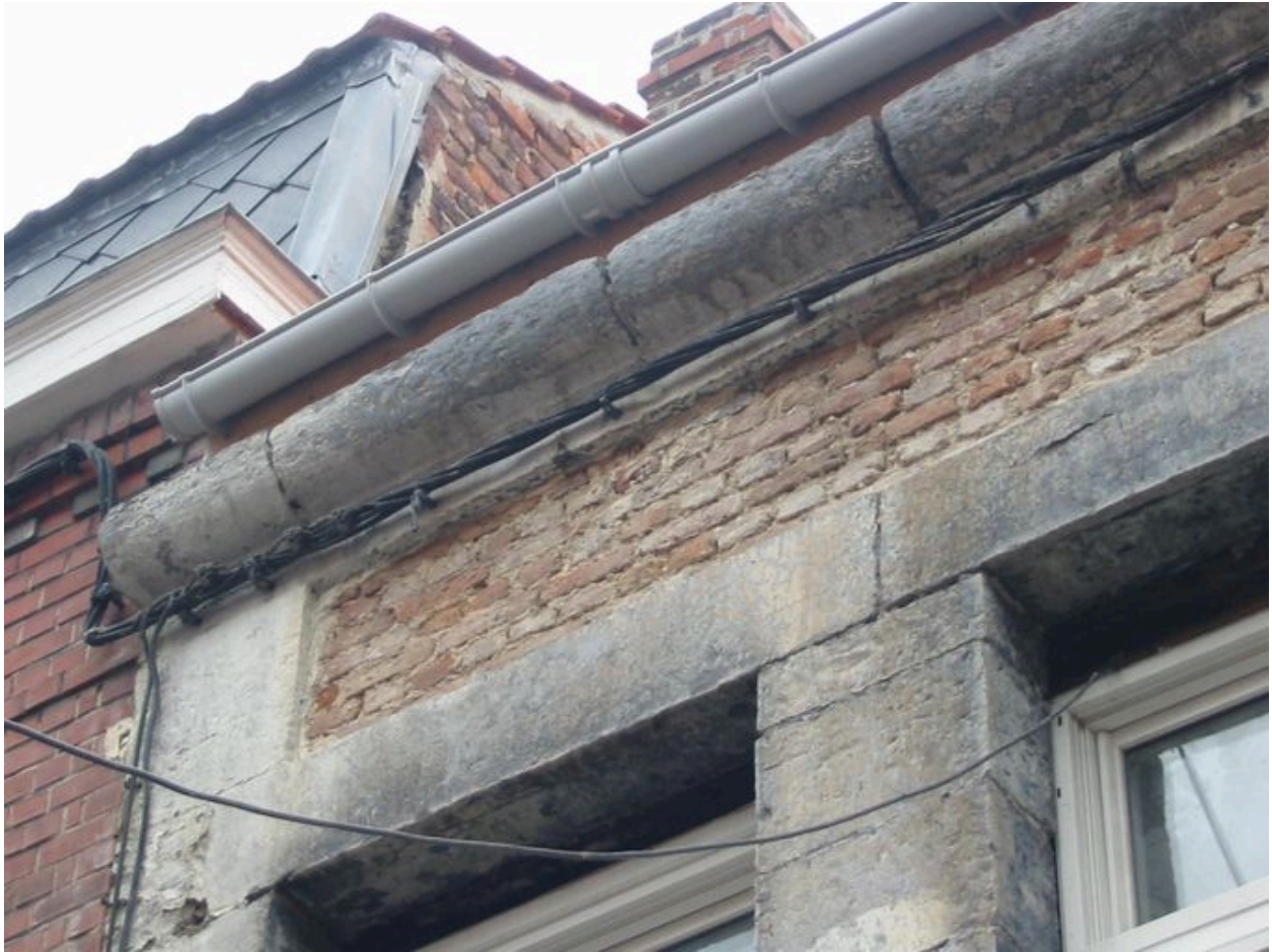
Façade, détail : corniche en quart de rond.
