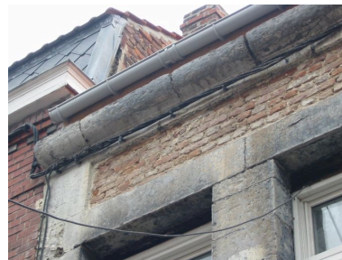
Façade, détail : corniche en quart de rond. Phot. François Bisman IVR31_20065906012NUCA
