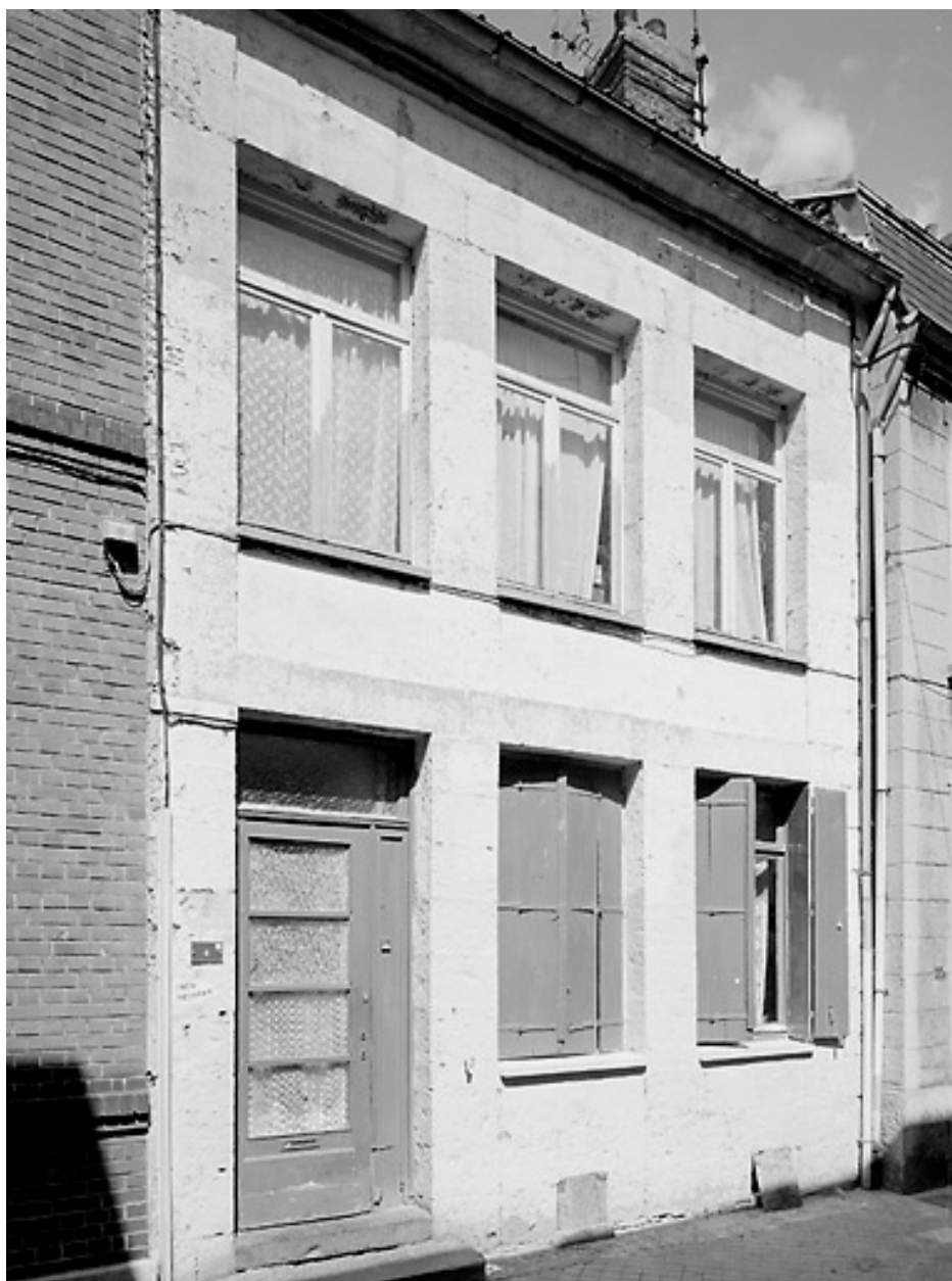
Vue générale, état en 2002, avant l'incendie.
