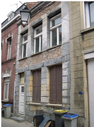
Vue générale en 2006. Phot. Anita Oger-Leurent IVR31_20065906011NUCA
