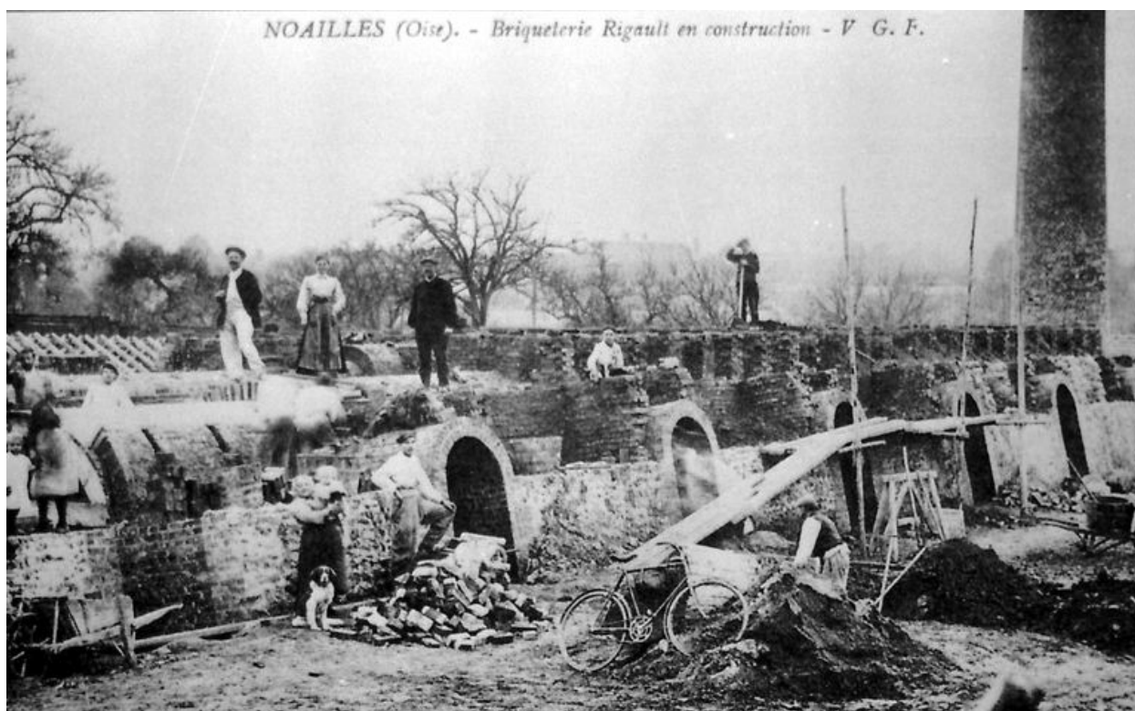
Construction du four à feu continu de type Hoffmann de la briqueterie, 1913 (carte postale, coll. part.).
