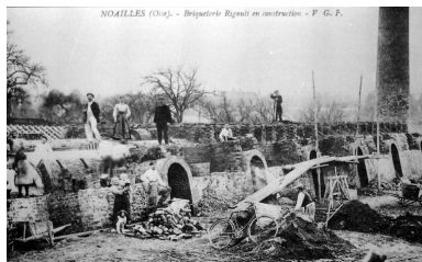
Construction du four à feu continu de type Hoffmann de la briqueterie, 1913 (carte postale, coll. part.). Phot. Bertrand Fournier IVR22_20006000186ZB
