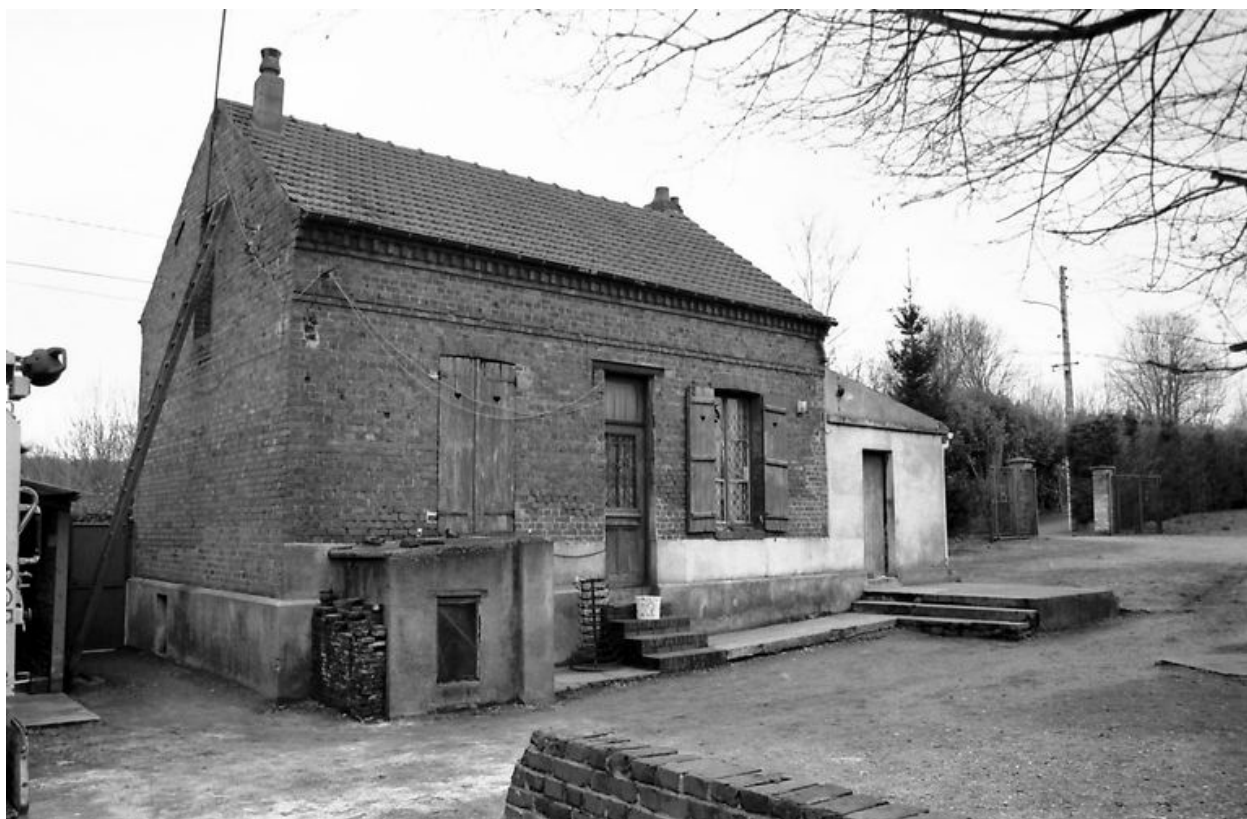
Maison de briquetier, façade sur cour.
