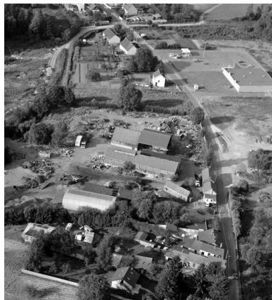
Vue aérienne du site industriel en 1994. Phot. Sanson Aviation IVR22_19946001743X
