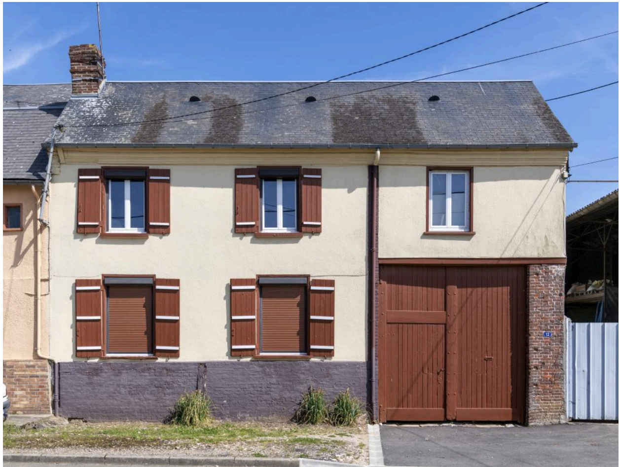
Logis sur rue avec entrée charretière, n°12 rue de la Ville, vue de la façade depuis le sud.
