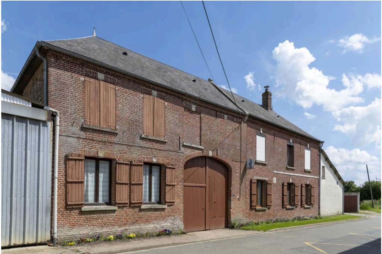
Logis de ferme sur rue (anciennement 2 fermes), n°7 rue Léger, vue de la façade depuis le nord-ouest.
