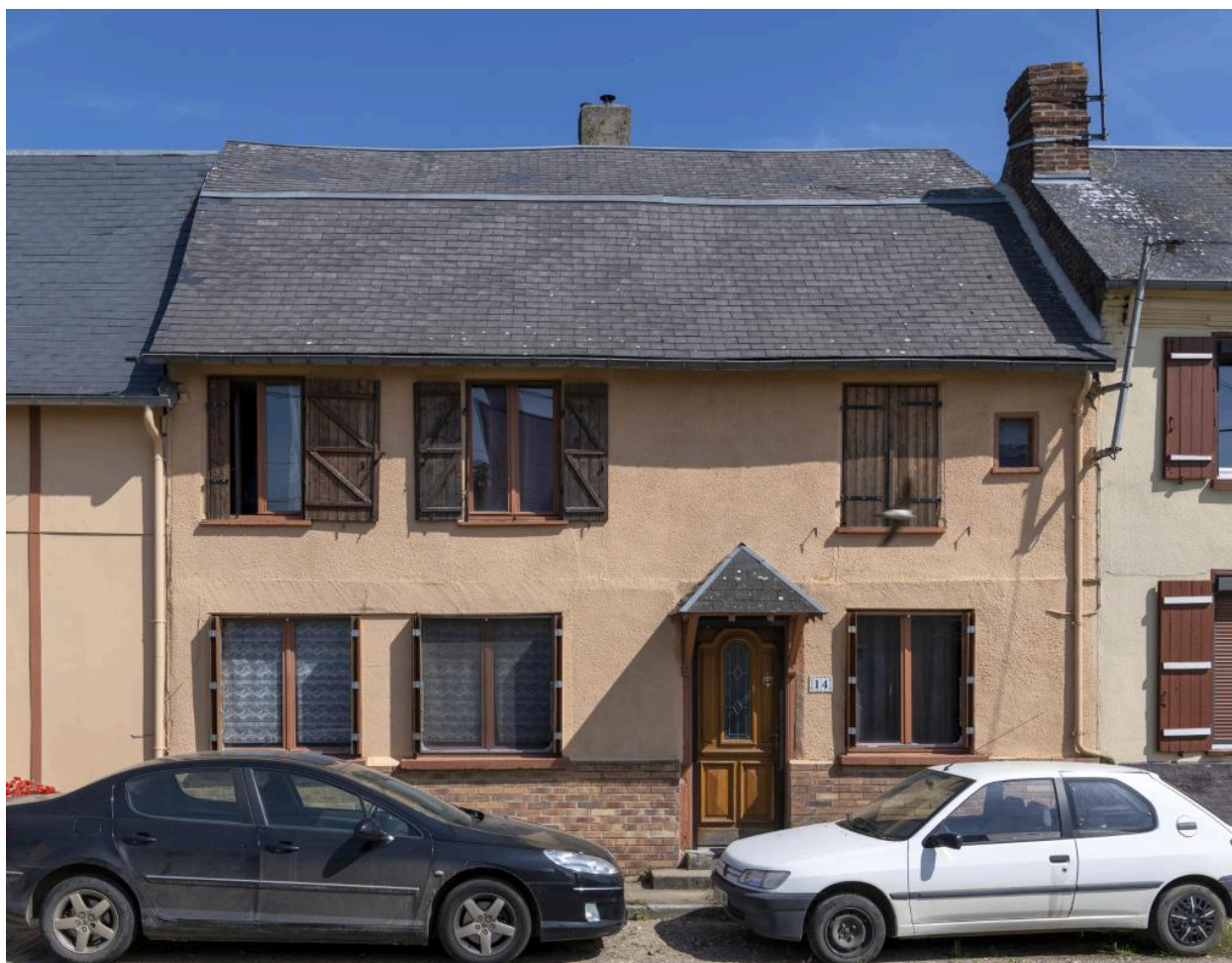
Ancien café, n°14 rue de la Ville, rue de la façade depuis la rue.
