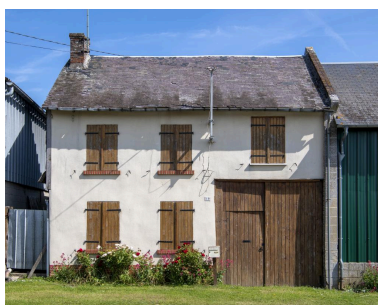
Logis sur rue avec entrée charretière, n°10 rue de la Ville, vue de la façade depuis le sud. Phot. Marc Kérignard IVR32_20216000580NUCA
