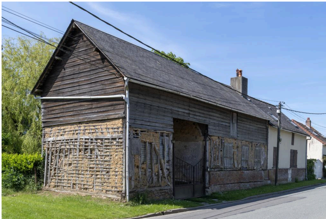
Logis prolongé d'une entrée charretière sur rue, n°15 rue Gaillard, vue depuis le nord-est.
