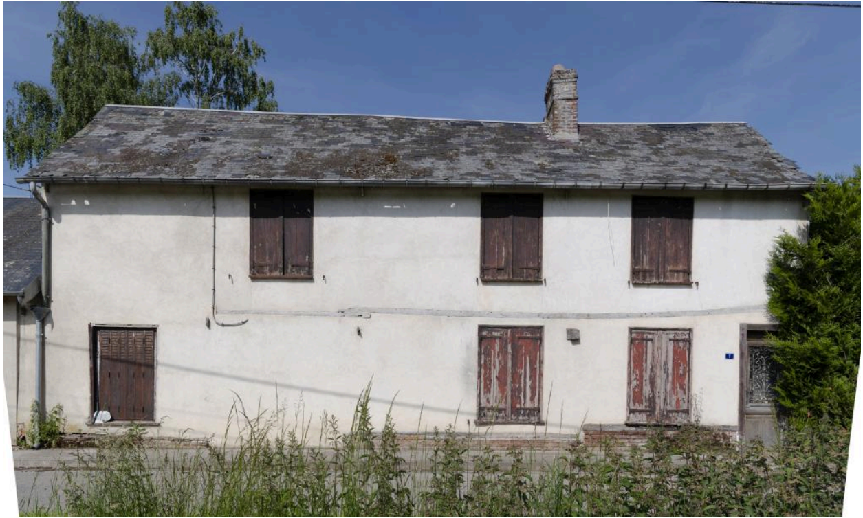
Logis sur rue, n°1 rue Cour Marin, vue de la façade depuis l'est.
