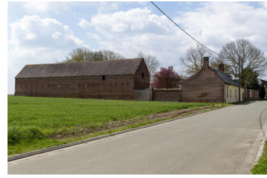
Ferme à cour, n°5 rue de Bonlier, vue depuis l'est. Phot. Marc Kérignard IVR32_20216000286NUCA
