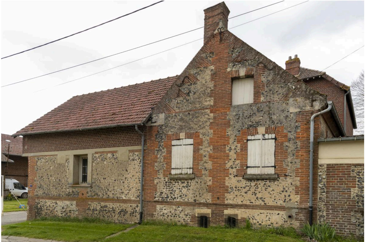
Pignon du logis de ferme, n°7 rue de Hénu, vue depuis le nord-est.
