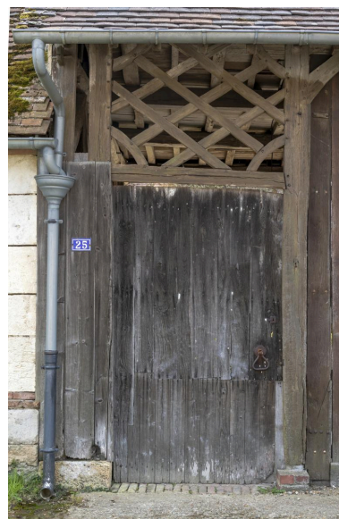
Porte piétonne avec imposte ajourée, n°25 rue de Bonlier, vue depuis le nord. Phot. Marc Kérignard IVR32_20216000281NUCA
