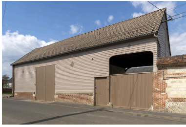
Ancienne grange essentée en bois, n°14 rue de Bonlier, vue depuis le sud. Phot. Marc Kérignard IVR32_20216000284NUCA
