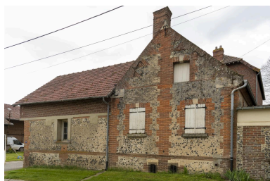
Pignon du logis de ferme, n°7 rue de Hénu, vue depuis le nord-est. Phot. Marc Kérignard IVR32_20226005047NUCA
