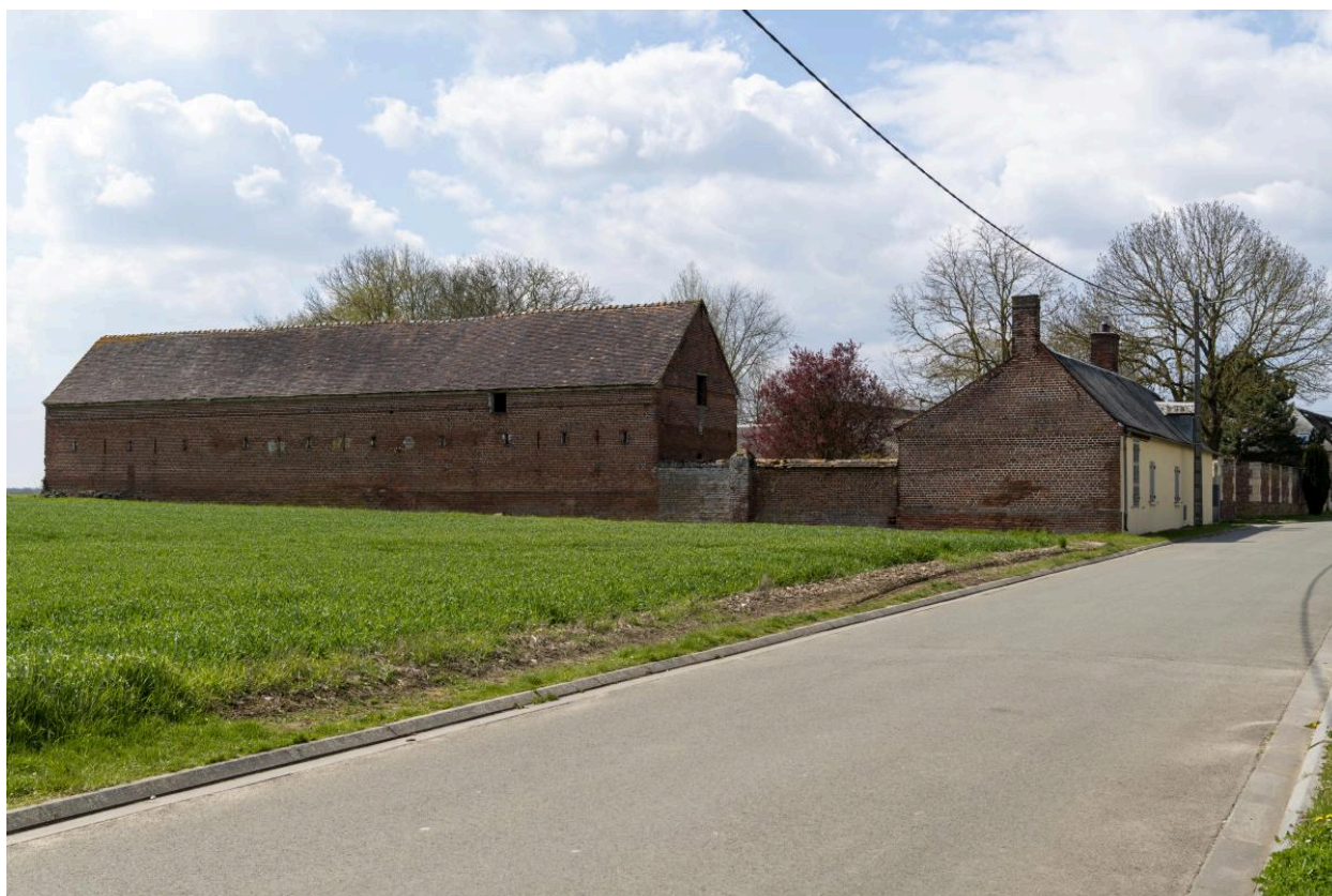
Ferme à cour, n°5 rue de Bonlier, vue depuis l'est.
