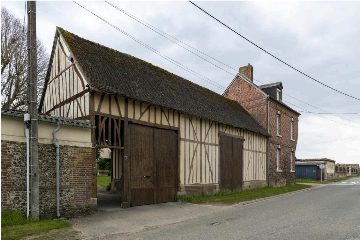
Grange et entrée charretière sur rue, n°5 rue de Hénu, vue depuis le sud-est.
