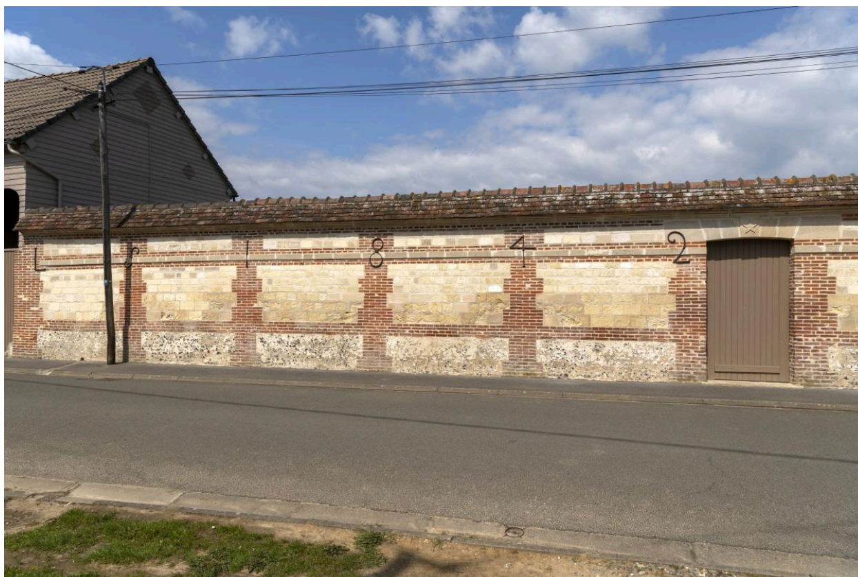
Mur daté de 1842, n°14 rue de Bonlier, vue depuis le sud.
