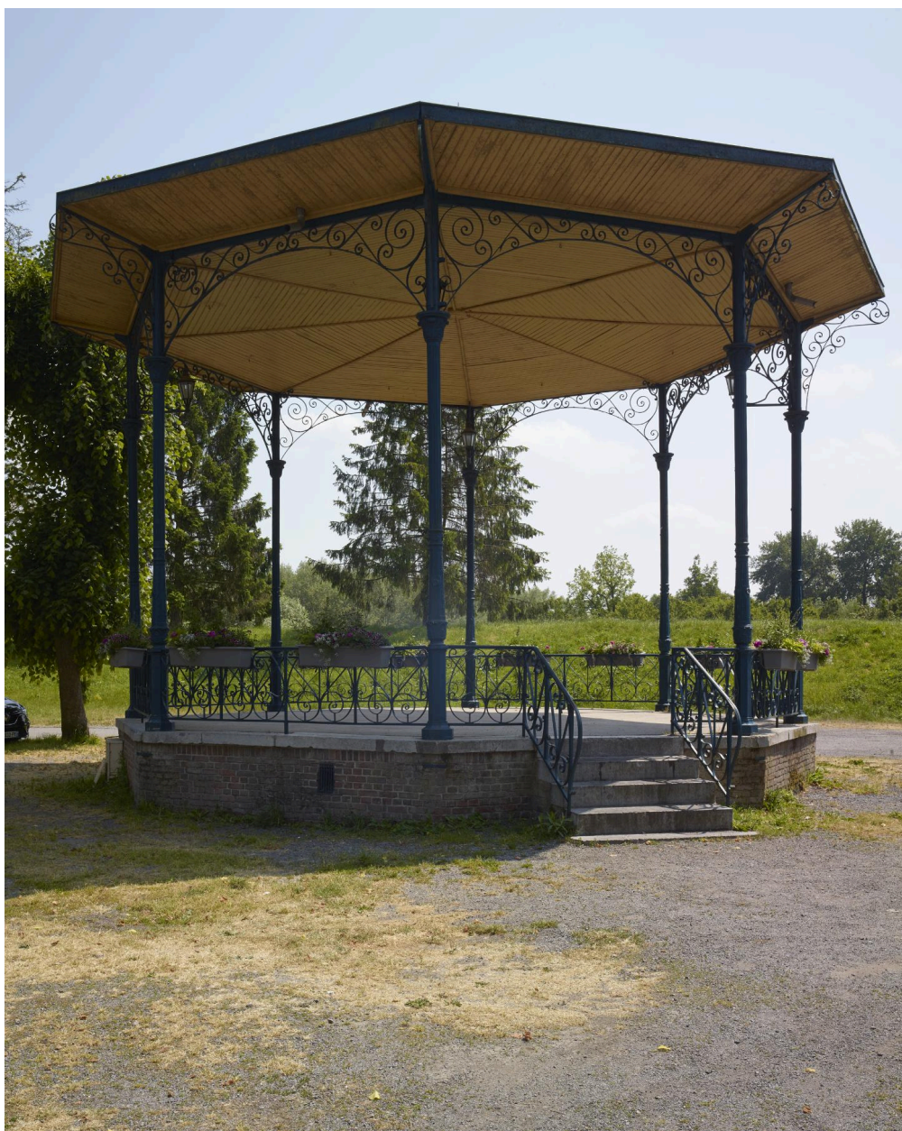
Kiosque à musique : vue générale, orientée sud/nord.
