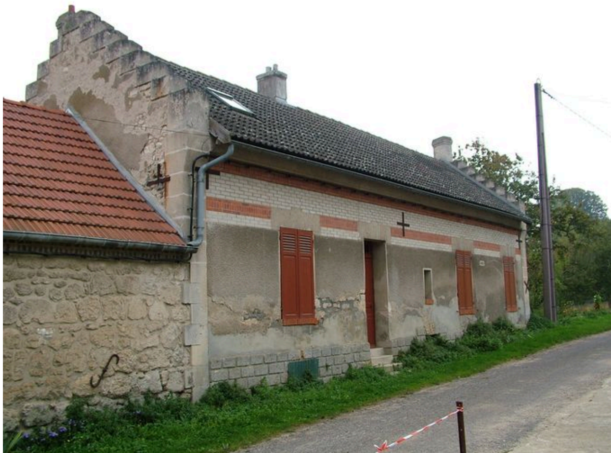
Vue postérieure du logis.
