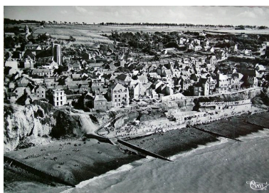
Les cabines de bains de Lefèvre, état après 1945, carte postale, 3e quart 20e siècle (coll. part.). Phot. Monnehay-Vulliet Marie-Laure IVR22_20048000099NUCAB
