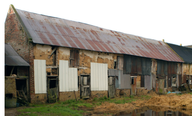
Vue générale des dépendances depuis la cour. Phot. Thierry Lefébure IVR22_20038001125NUCA
