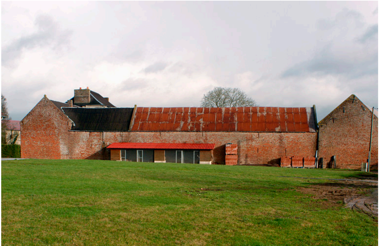
Vue générale des dépendances, depuis la rue.
